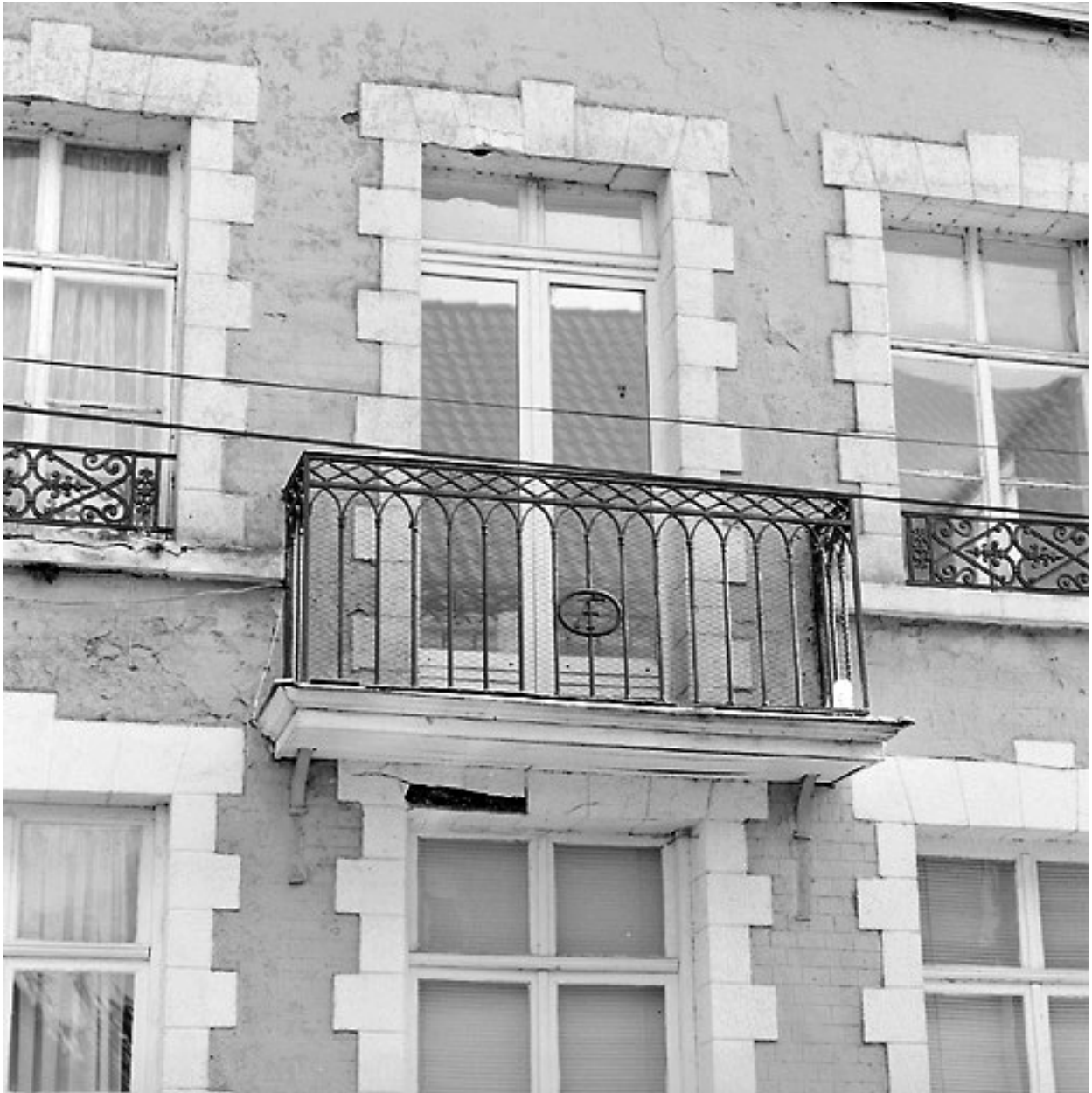
Aile faisant retour sur la rue de la Hainette, détail : balcon.
