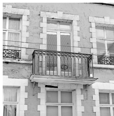
Aile faisant retour sur la rue de la Haynette, détail : balcon. Phot. Pierre Thibaut IVR31_20055900837X
