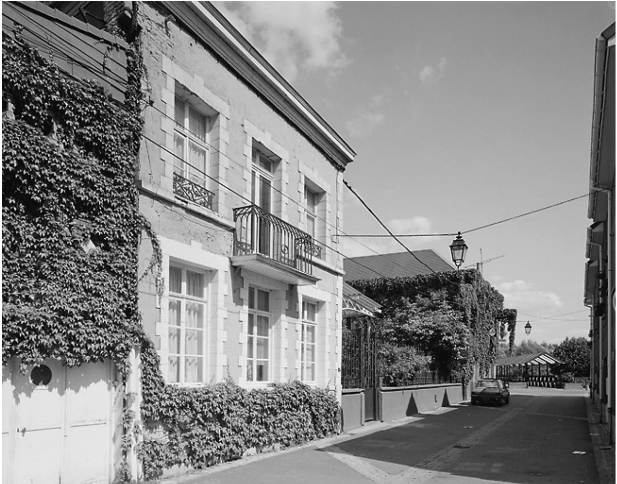
Aile faisant retour sur la rue de la Hainette (état en 2002).
