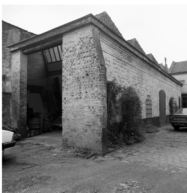
Ancien magasin industriel (cf. angle de prise de vue 7). Phot. Philippe Dapvril IVR31_19885900776X
