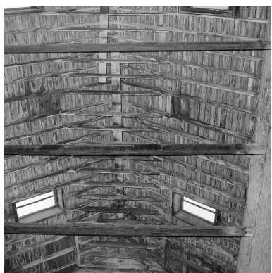
Pièce de séchage, couverture (cf. angle de prise de vue 6). Phot. Philippe Dapvril IVR31_19885900805X
