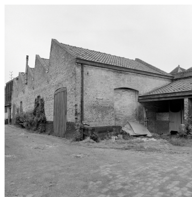
Ancien atelier de fabrication (cf. angle de prise de vue 8). Phot. Philippe Dapvril IVR31_19885900779X
