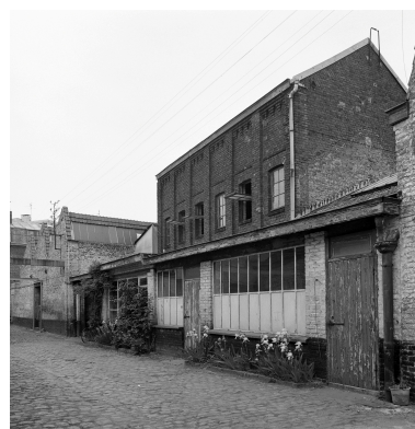
Pièce de séchage vers l'ouest (cf. angle de prise de vue 5). Phot. Philippe Dapvril IVR31_19885900777X
