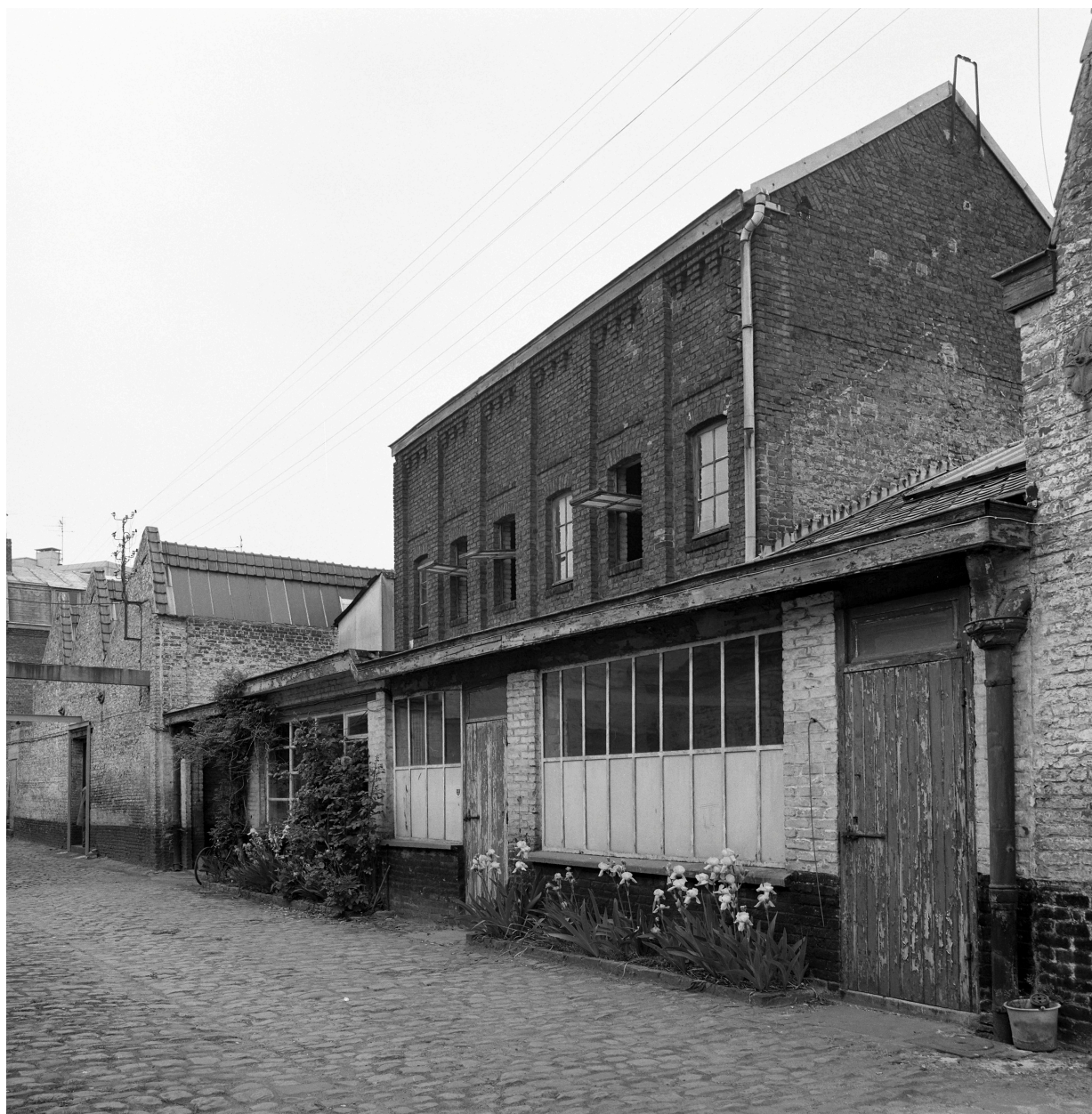
Pièce de séchage vers l'ouest (cf. angle de prise de vue 5).
