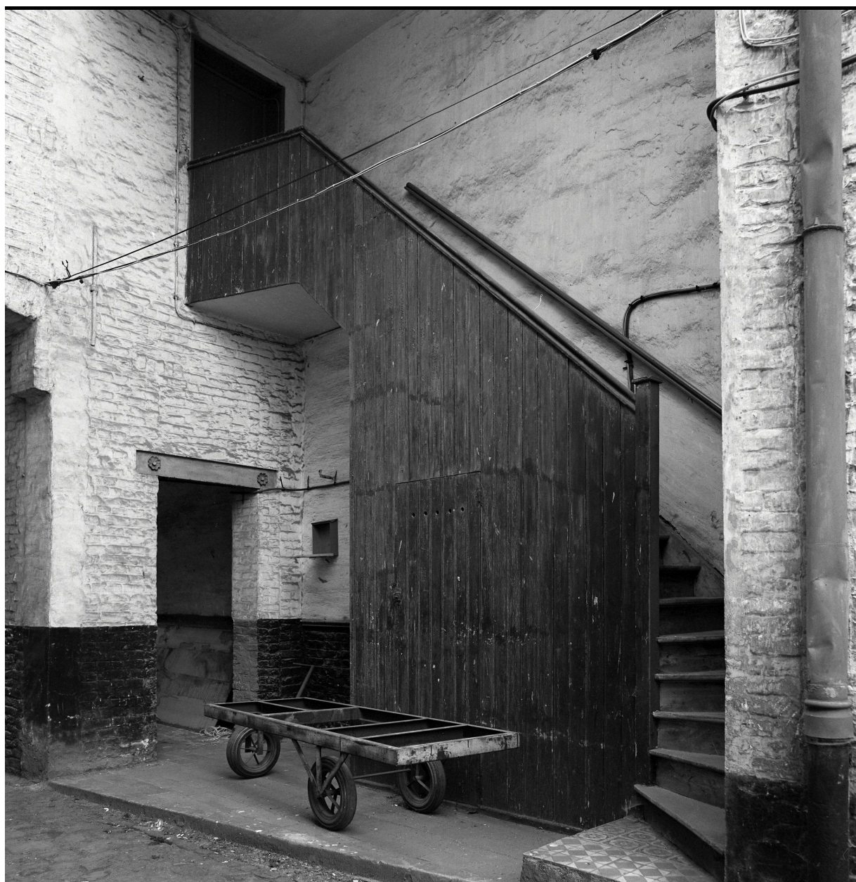
Escalier menant au logement patronal (cf. angle de prise de vue 3).
