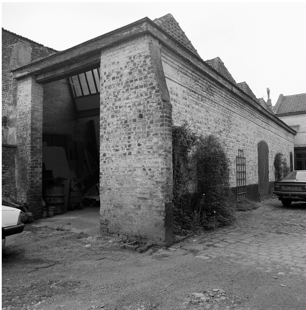
Ancien magasin industriel (cf. angle de prise de vue 7).
