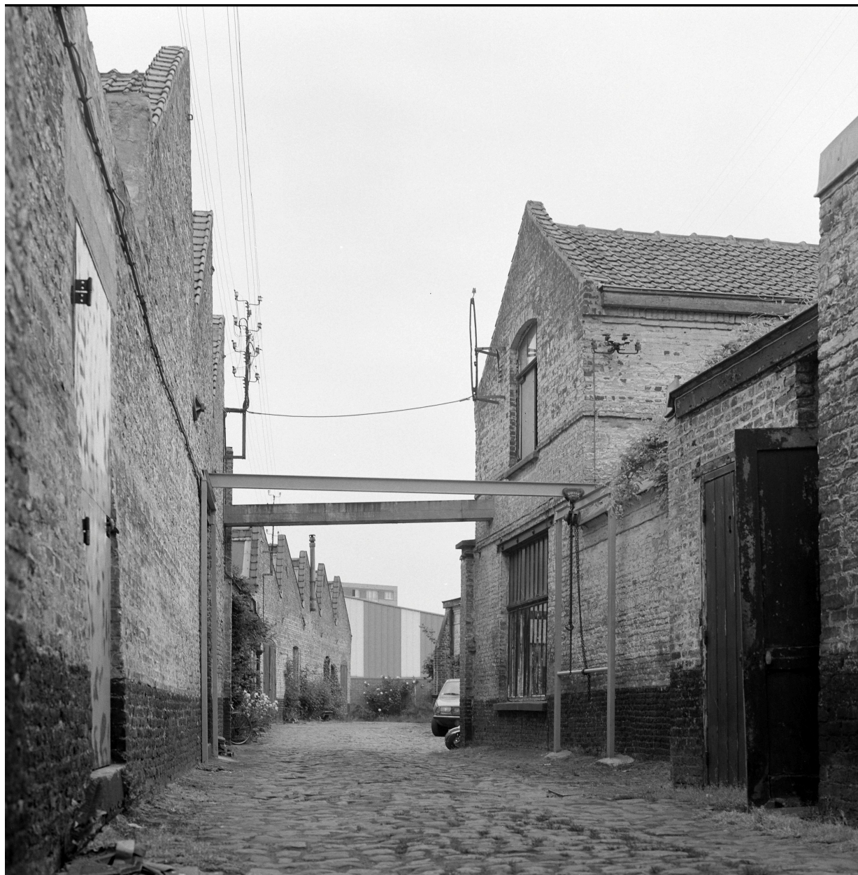
Vue générale vers l'est (cf. angle de prise de vue 4).
