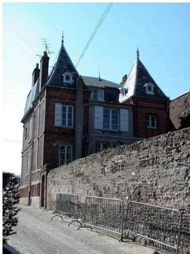
Elévation postérieure. Phot. Elisabeth Justome IVR22_20058003773NUCA
