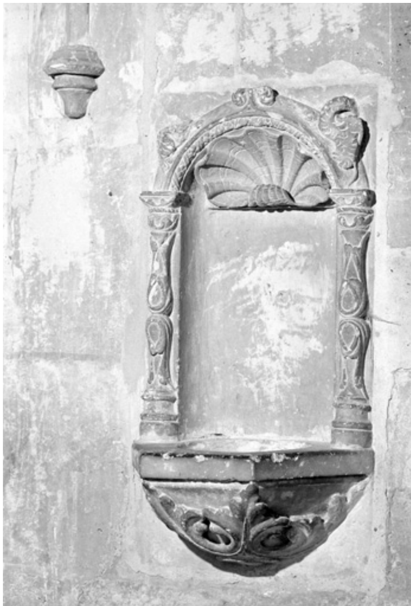
Niche de la chapelle abritant le lavabo.
