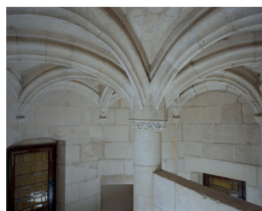
La voûte vue de côté. Phot. Thierry Lefébure IVR22_19940200822VA
