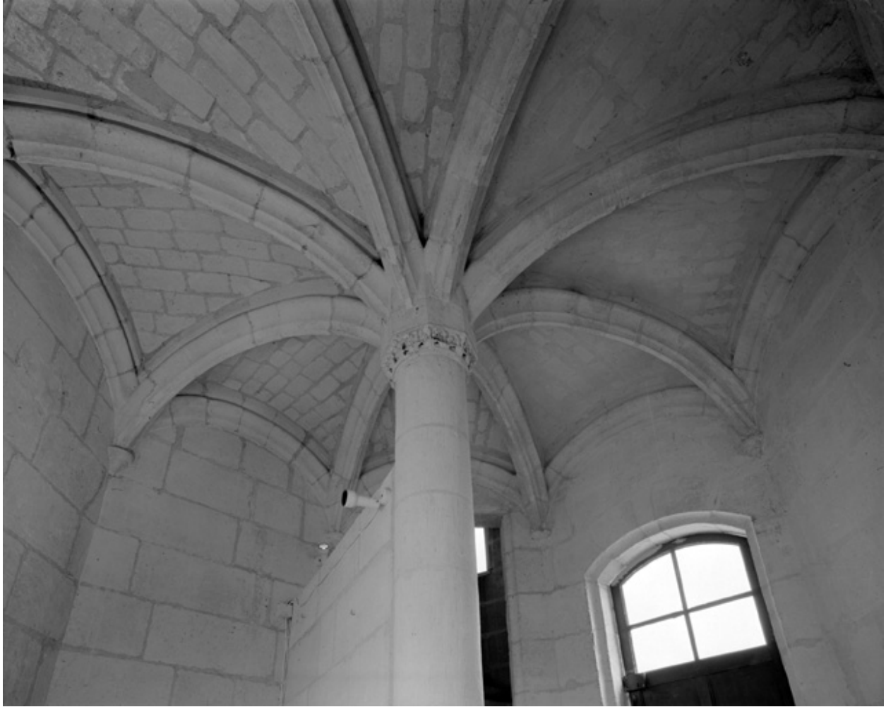
La voûte de la cage d'escalier.
