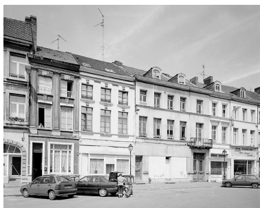
Rang nord-ouest de la place Pierre-Delcourt, vue partielle : maisons n° 18 et 20 à la suite de l'ensemble du corps de garde, à gauche (état en 2001). Phot. Pierre Thibaut IVR31_20015901180V
