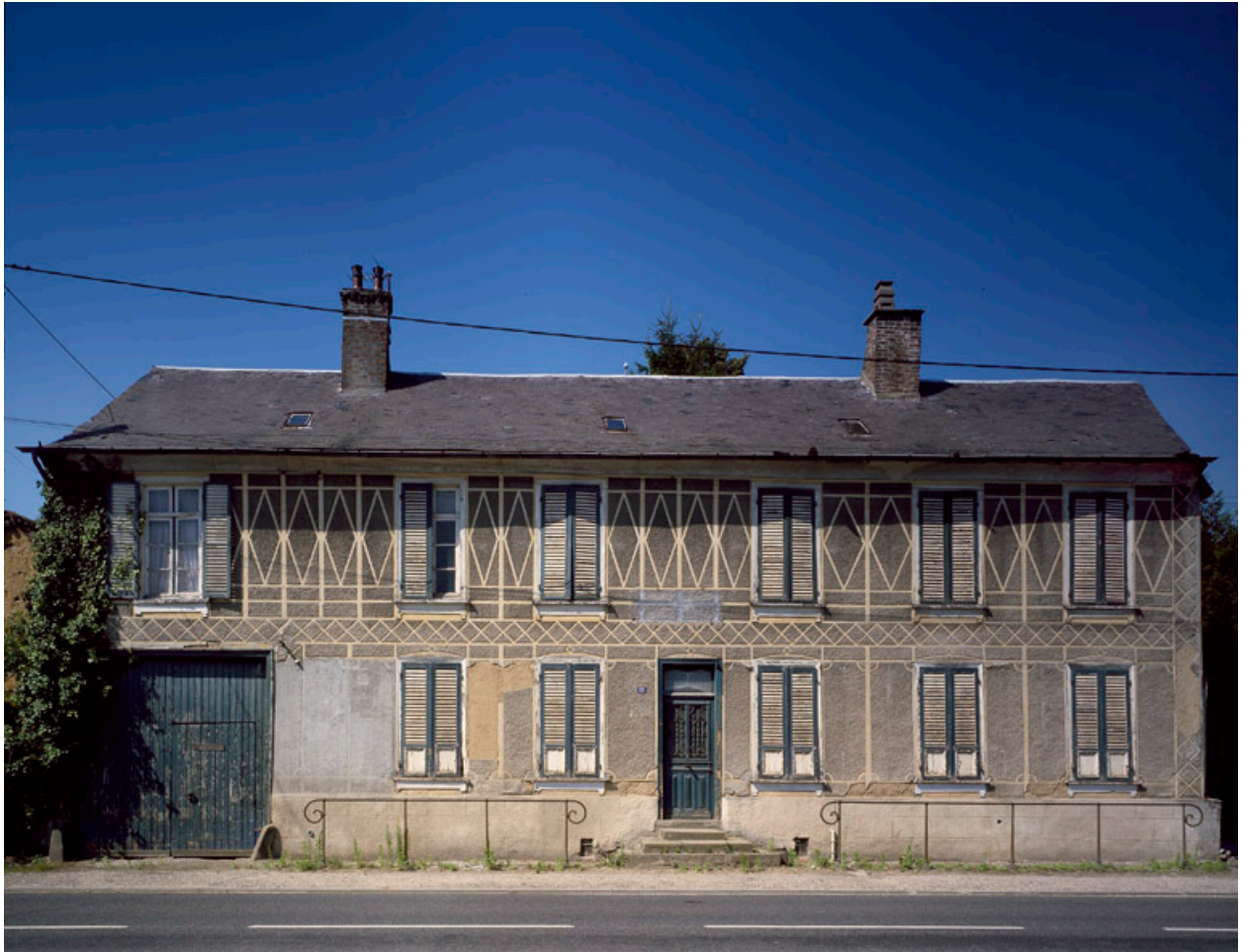
Vue générale, depuis la route d'Amiens.
