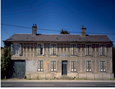
Vue générale, depuis la route d'Amiens. Phot. Irwin Leullier IVR22_19998001759VA
