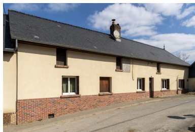
Ancien café, n°2 rue Lavaquerie. Phot. Marc Kérignard IVR32_20216000202NUCA
