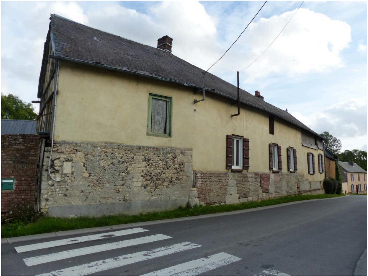
Logis de l'ancienne ferme du château Lesage, vers 1790, n°14 rue du Chauffour, vue depuis le nord.
