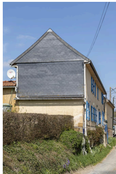
Pignon essenté en ardoise, détail du logis n°3 rue du Chauffour, vue depuis le sud. Phot. Marc Kérignard IVR32_20216000216NUCA
