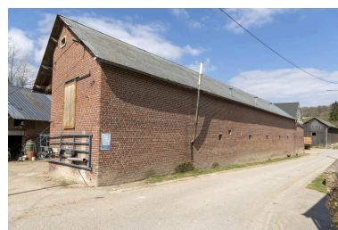
Étable, n°1 rue Lavaquerie, vue depuis la rue. Phot. Marc Kérignard IVR32_20216000201NUCA
