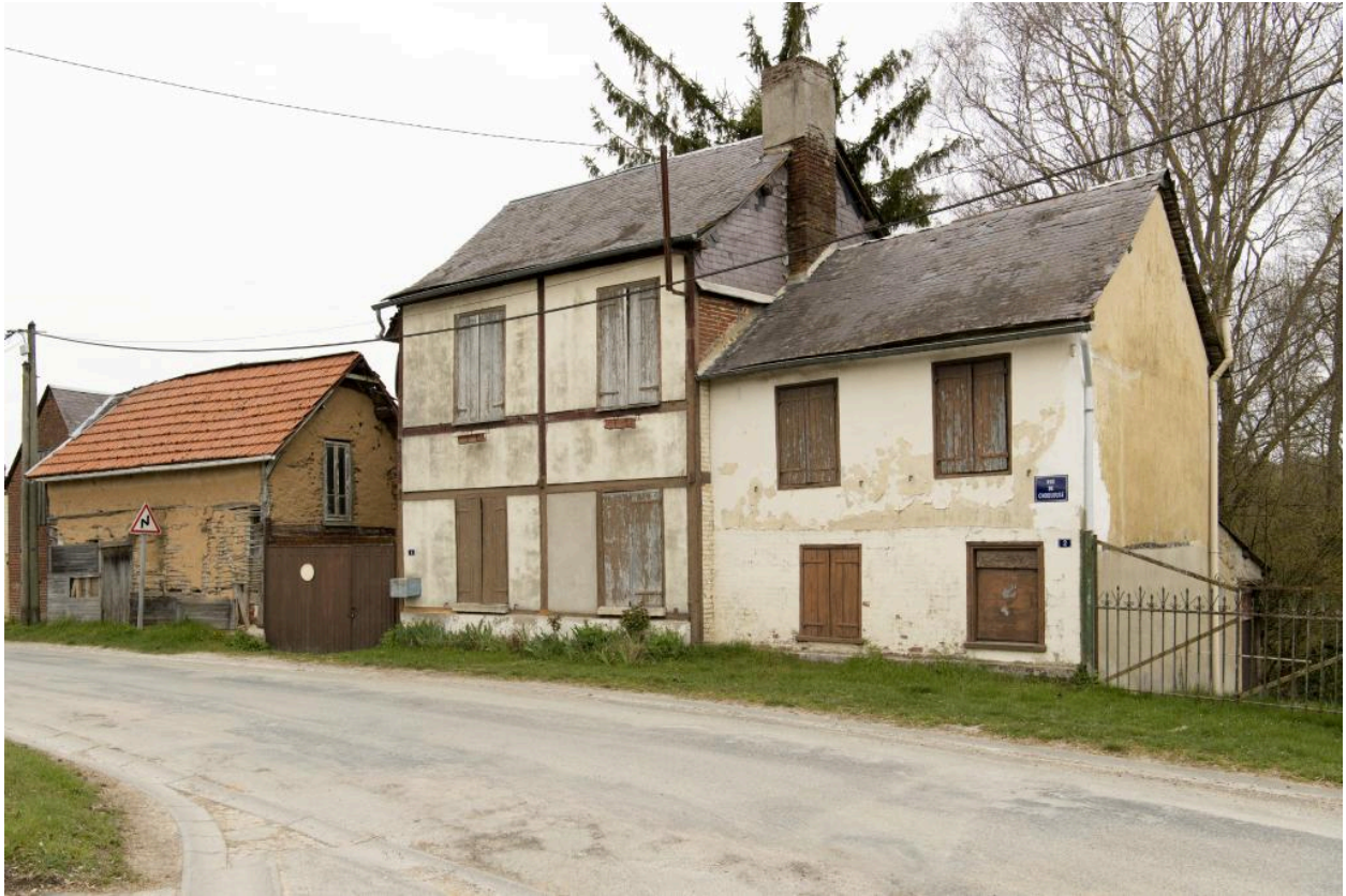
Vue depuis la rue de maisons d'artisans ou commerçants, n°2 et 4 rue de Choqueuse.
