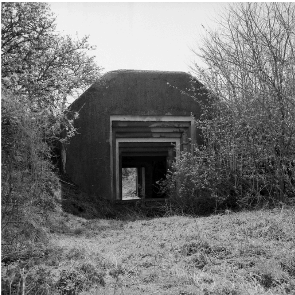
Vue générale depuis le nord.
