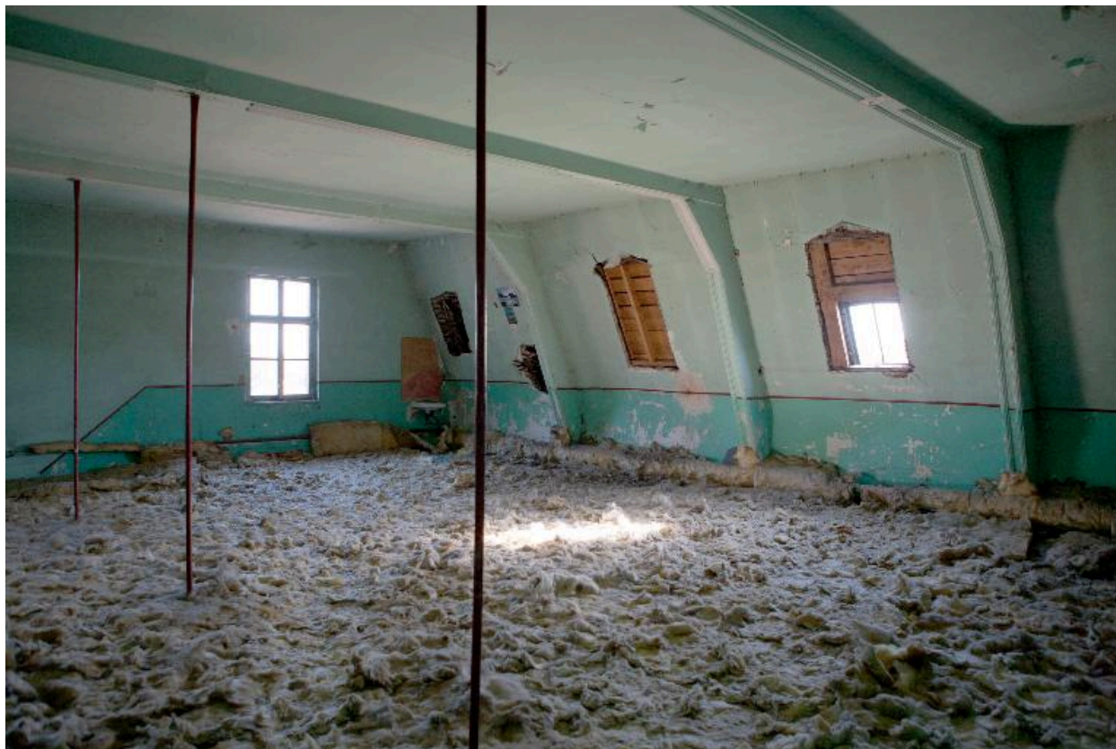
Etage de combles ayant abrité les dortoirs, le voûtement en béton.
