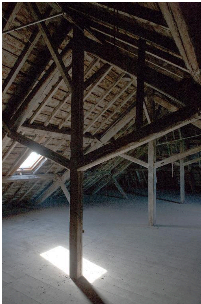
Les combles et la charpente du collège Notre Dame des Angés rue du Bruille.
