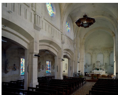
Vue intérieure. Phot. Thierry Lefébure IVR22_20068000463VA
