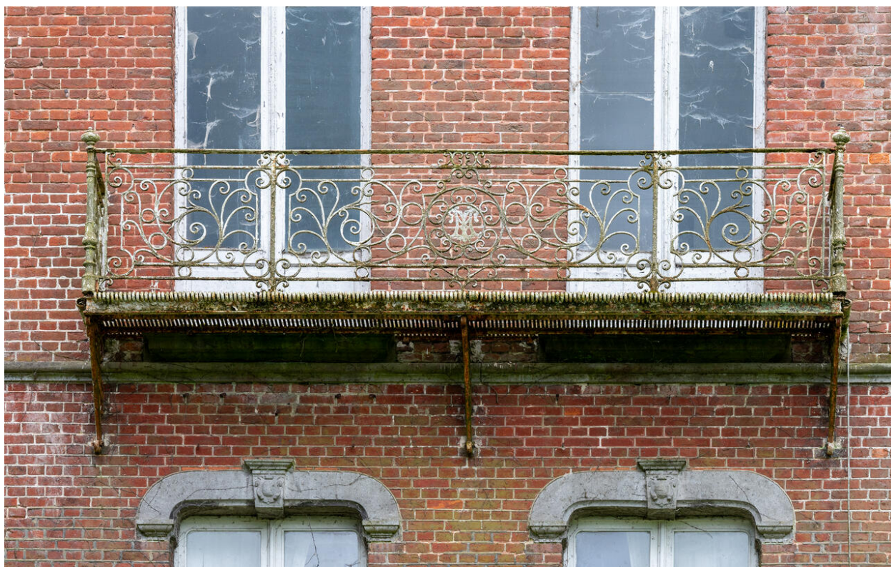
Élévation nord. Détail du balcon du second étage.
