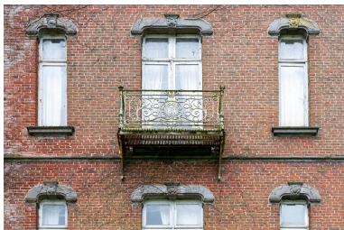
Élévation nord. Détail des baies du deuxième étage. Phot. Pierre Thibaut IVR32_20245902204NUCA
