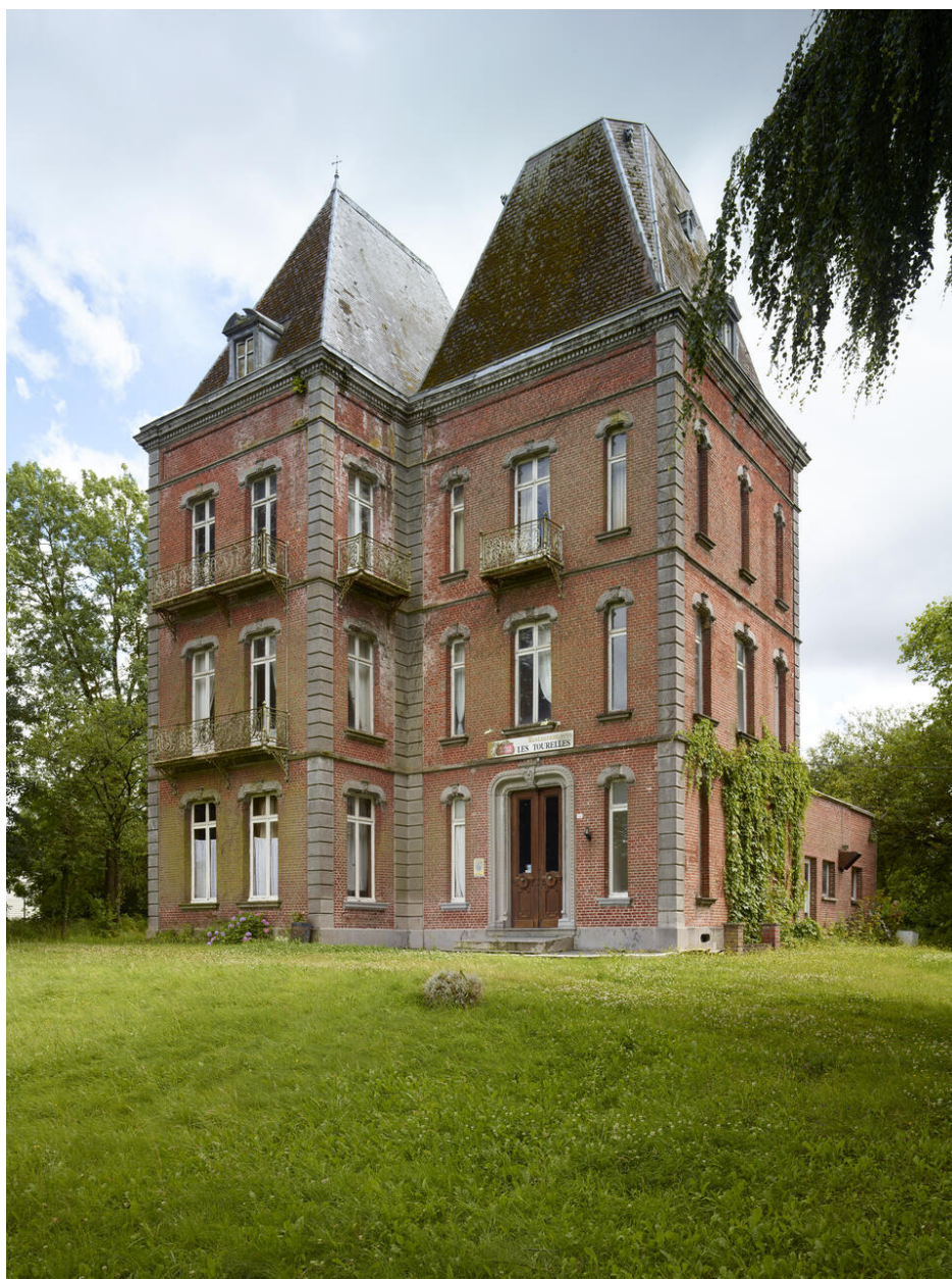
Vue de trois quarts vers le sud-est.
