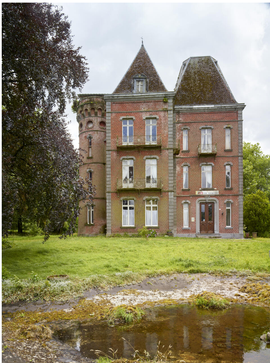
Élévation nord, depuis le parc.
