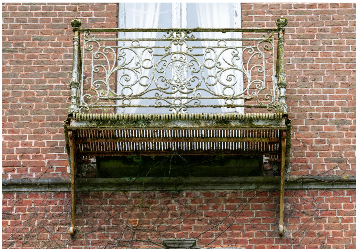
Élévation nord. Détail du balconnet du deuxième étage.
