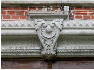
Détail de l'archivolte de l'entrée de l'élévation nord. Phot. Pierre Thibaut IVR32_20245902200NUCA
