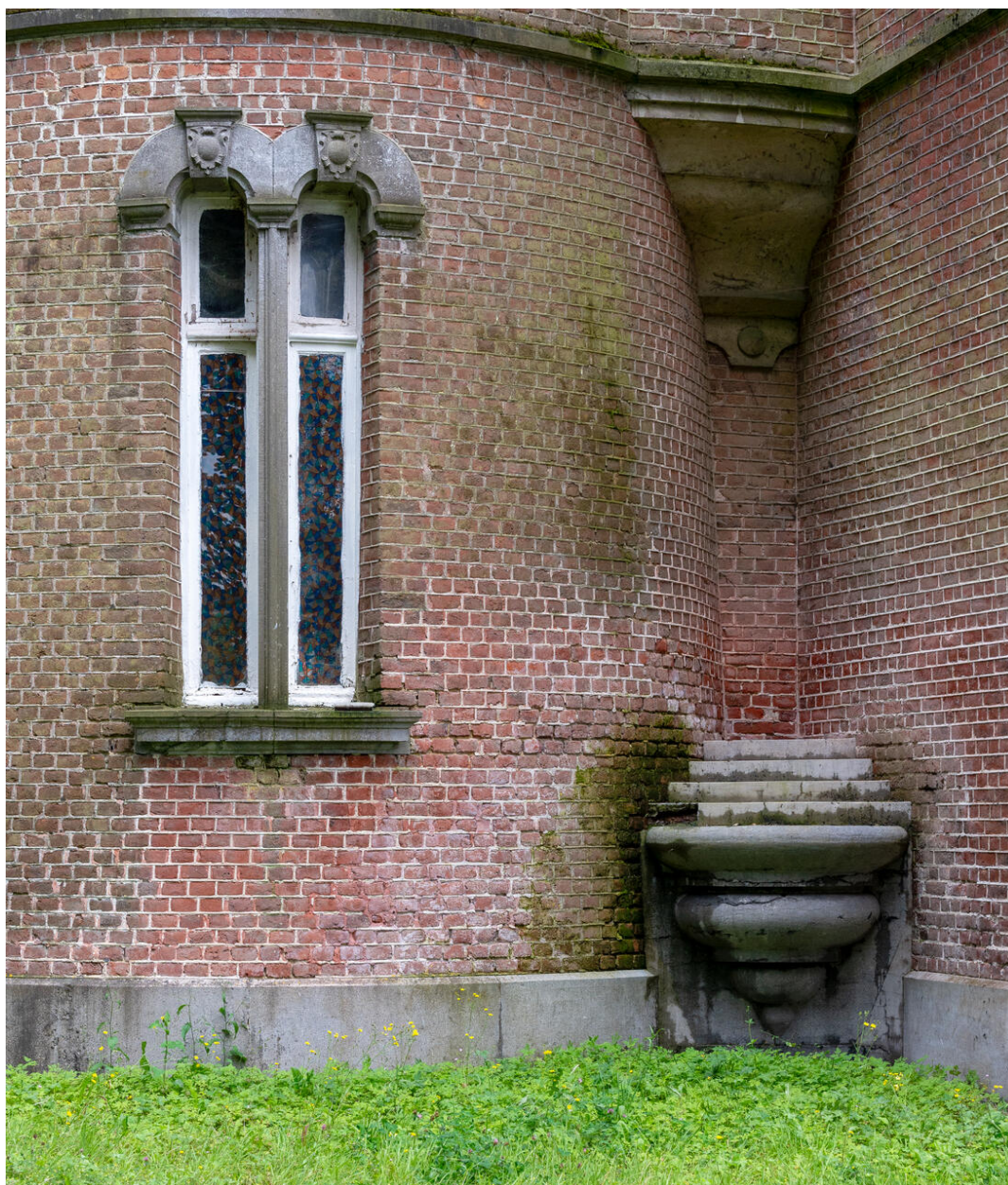
Tourelle est. Détail.
