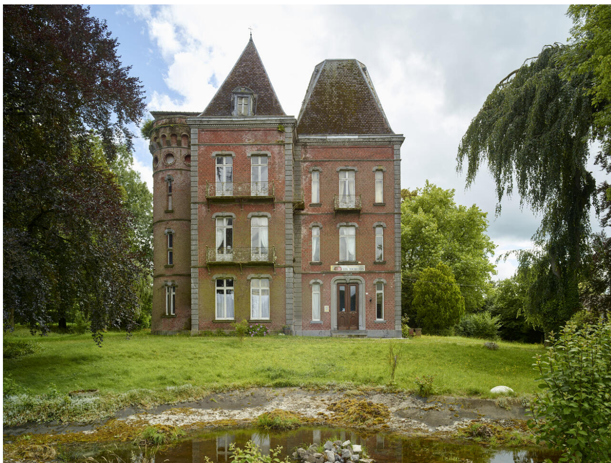
Élévation nord, depuis le parc.
