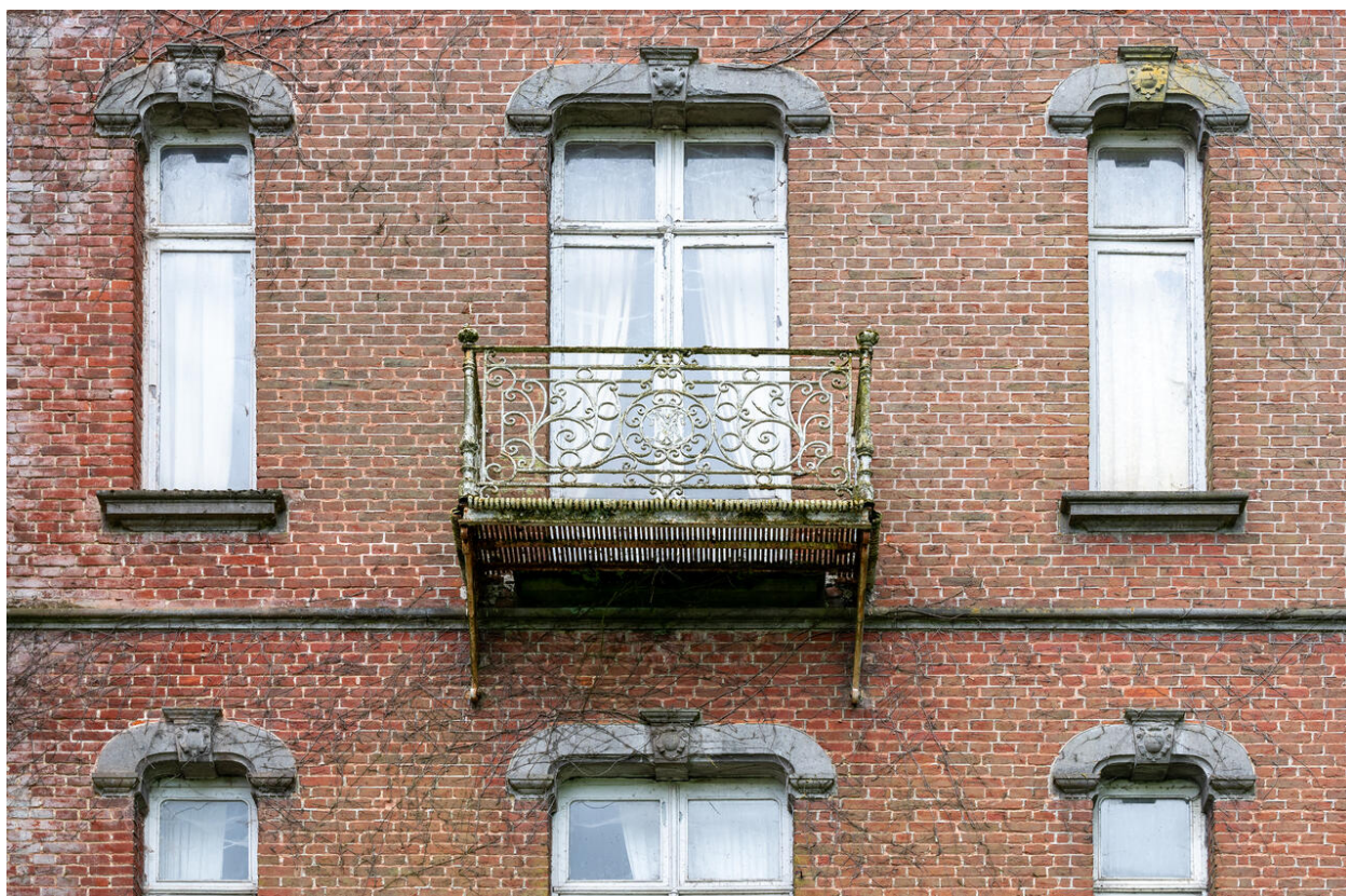
Élévation nord. Détail des baies du deuxième étage.
