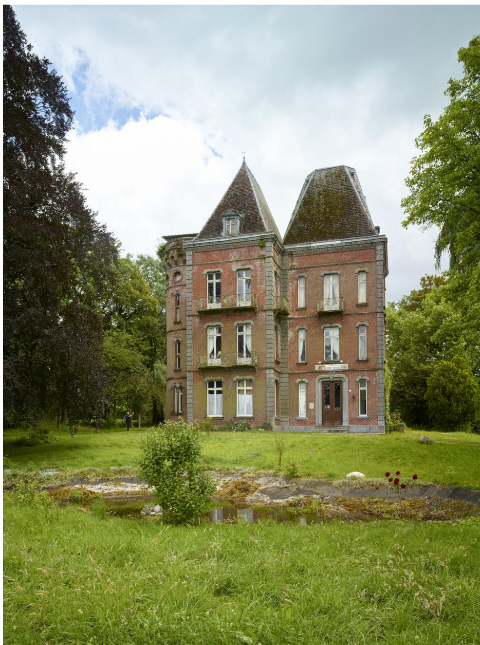
Élévation nord, depuis le parc.
