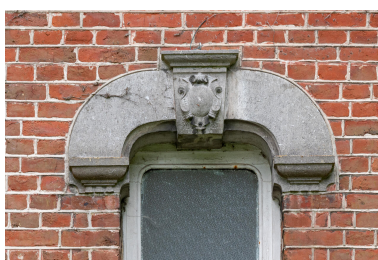
Archivolte en pierre sculptée d'une baie simple (à un vantail). Phot. Pierre Thibaut IVR32_20245902201NUCA
