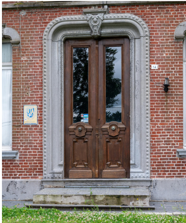
Archivolte et encadrement en pierre sculptée de l'entrée de l'élévation nord. Phot. Pierre Thibaut IVR32_20245902202NUCA
