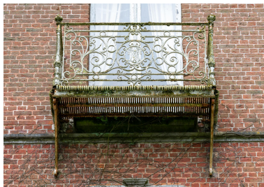
Élévation nord. Détail du balconnet du deuxième étage. Phot. Pierre Thibaut IVR32_20245902205NUCA
