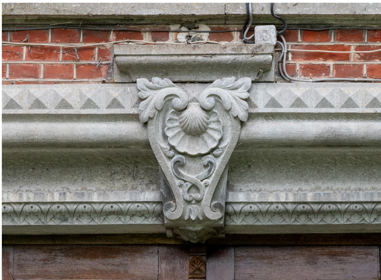
Détail de l'archivolte de l'entrée de l'élévation nord.
