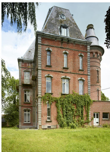
Élévation ouest. Phot. Pierre Thibaut IVR32_20245902192NUCA
