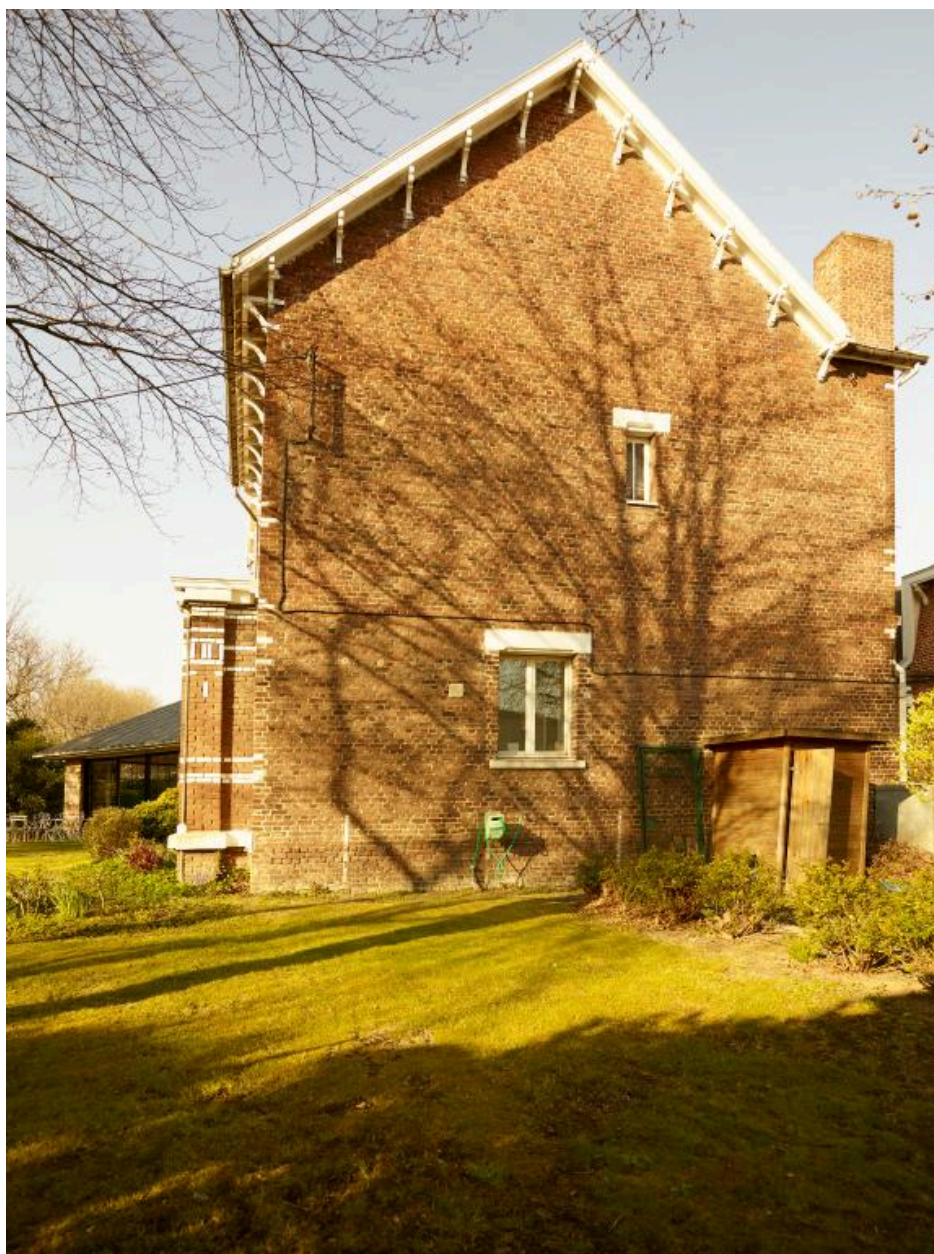
Logement patronal, pignon ouest.
