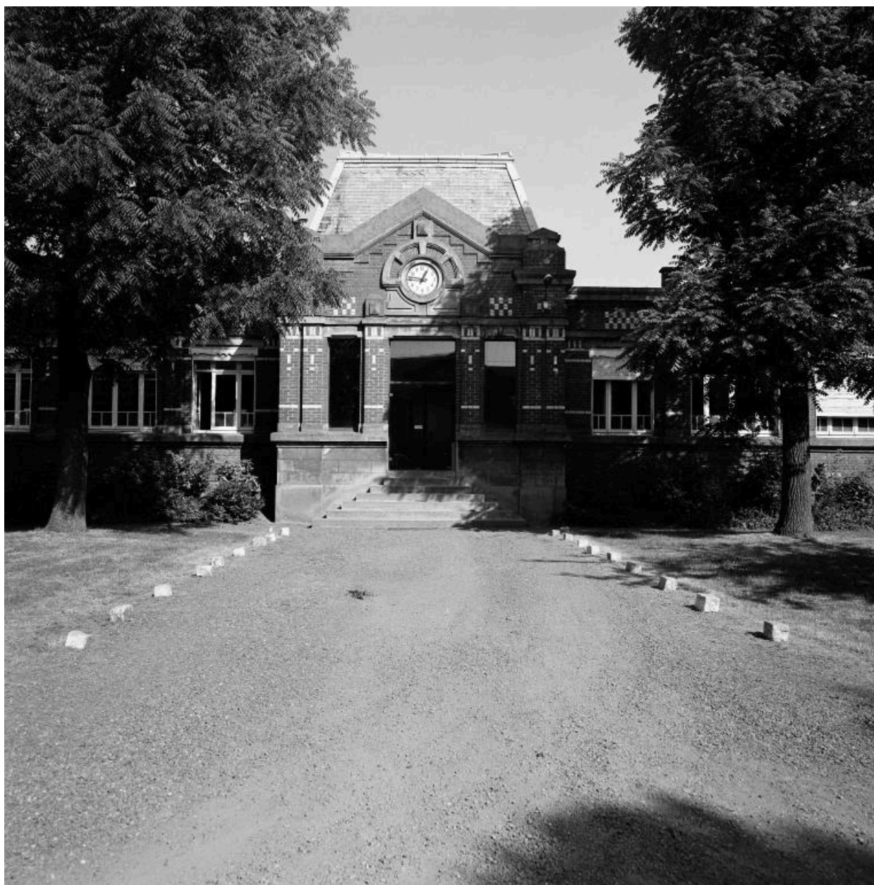
Bureaux vus depuis l'entrée. Corps central.
