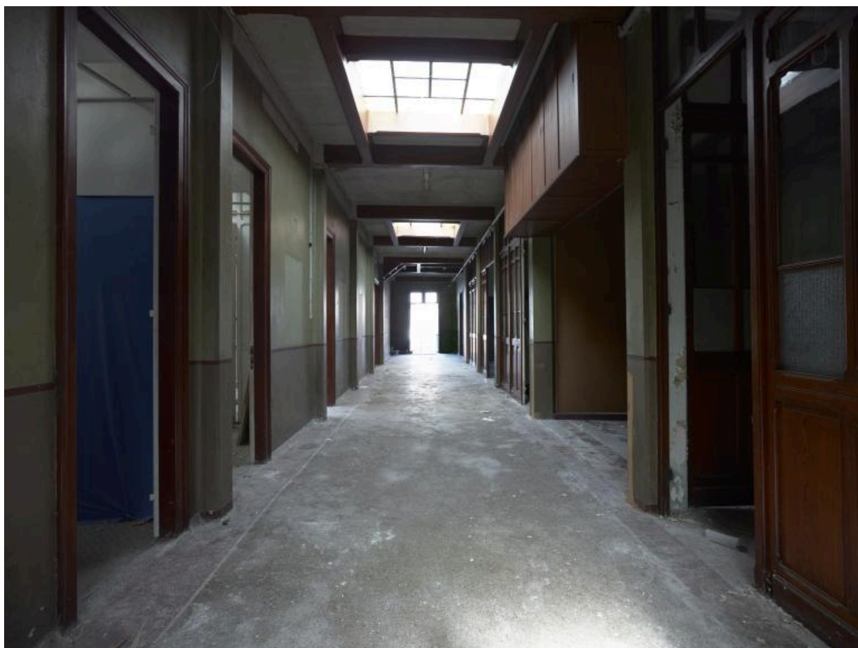
Bureaux. Couloir longitudinal vers l'est.
