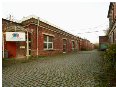
Magasin aux toiles. Vue prise vers l'ouest.
