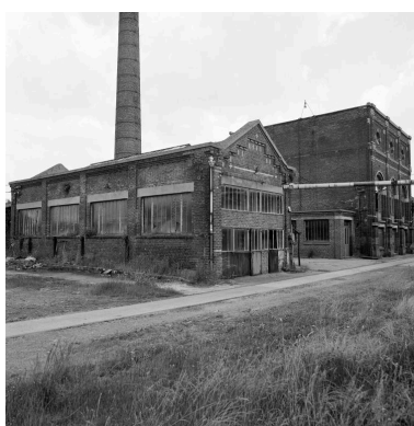
Chaudière, à gauche, et salle des machines à droite. Vue prise vers l'est.
