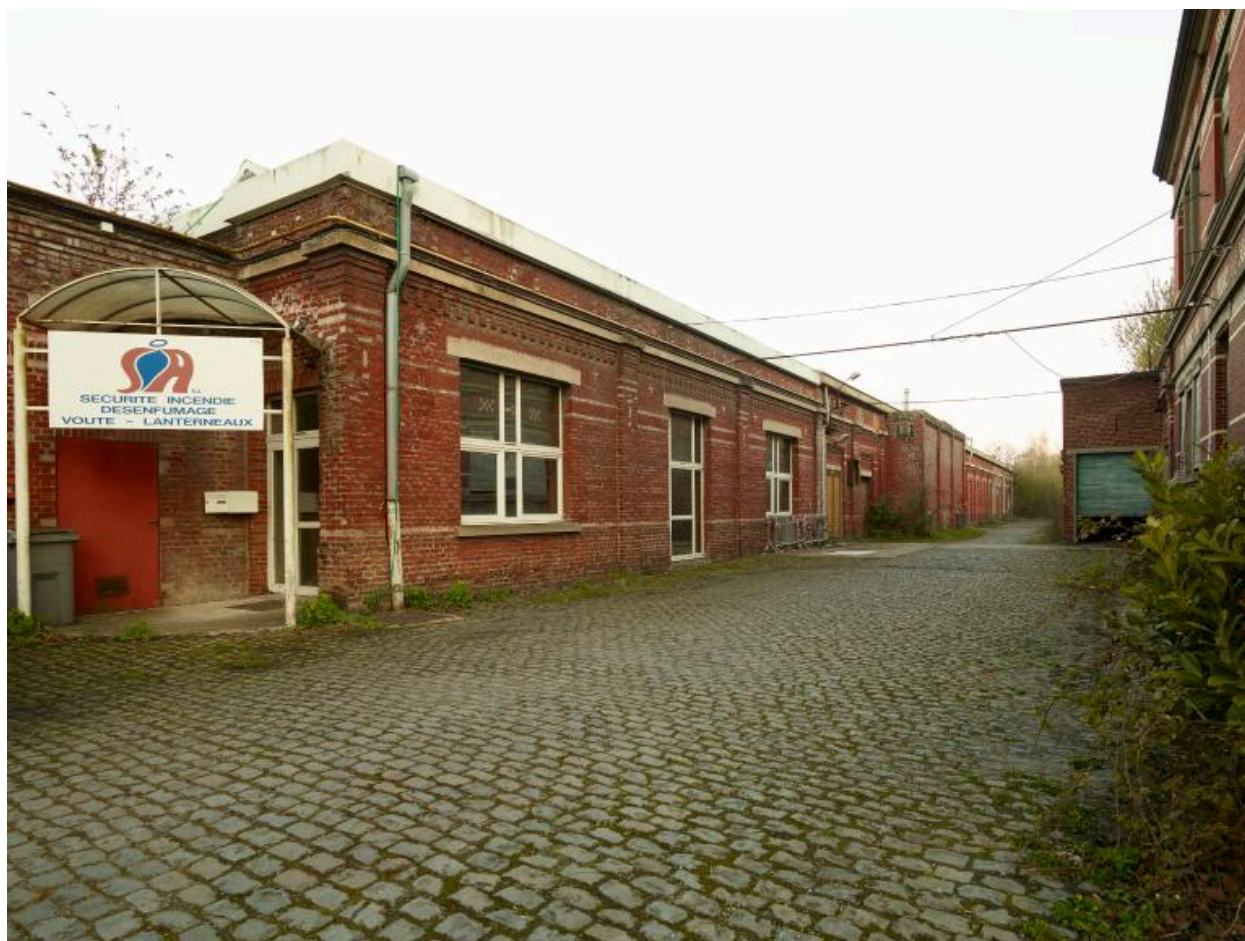
Magasin au toiles. Vue prise vers l'ouest.
