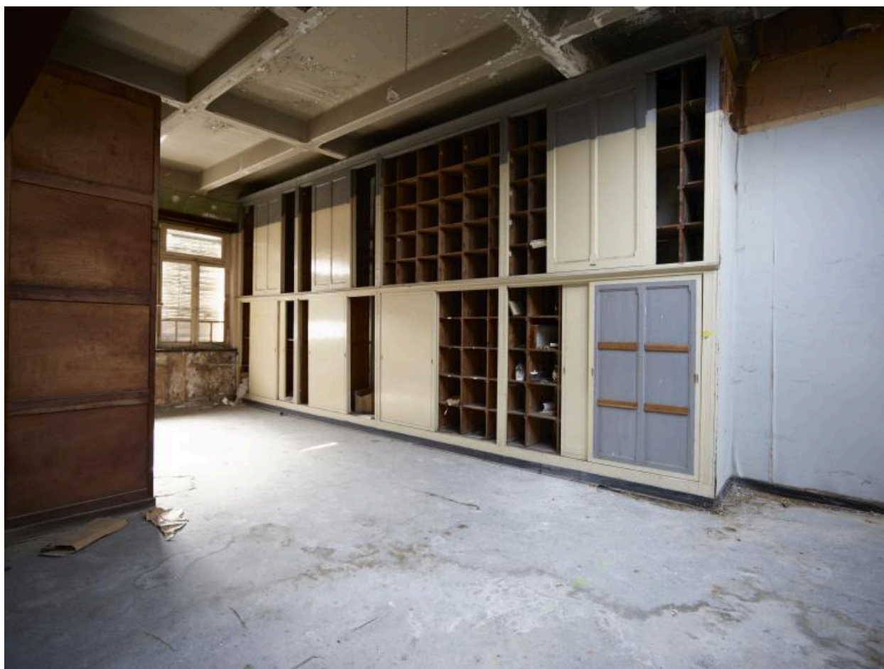
Bureaux. Salle des archives au premier étage.
