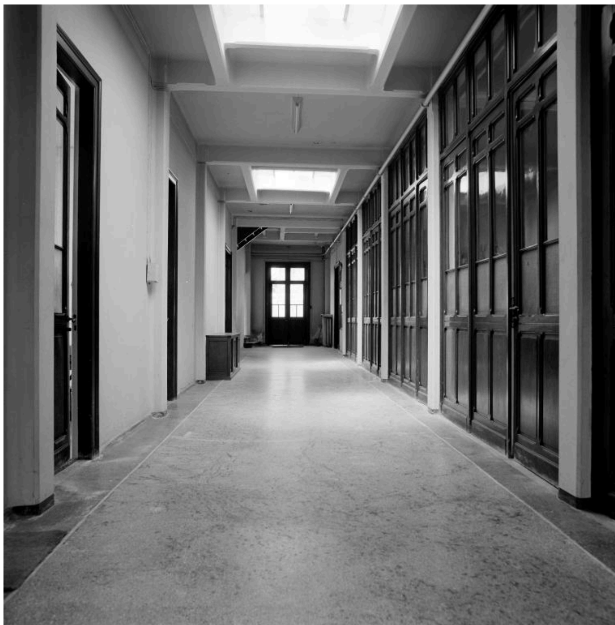
Bureaux. Couloir longitudinal.
