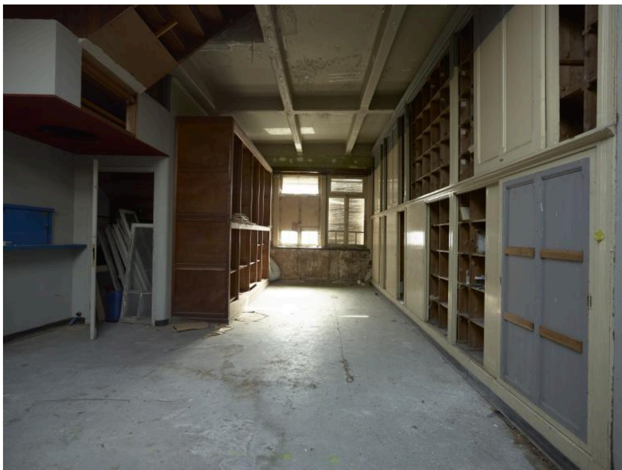
Bureaux. Salle des archives au premier étage.
