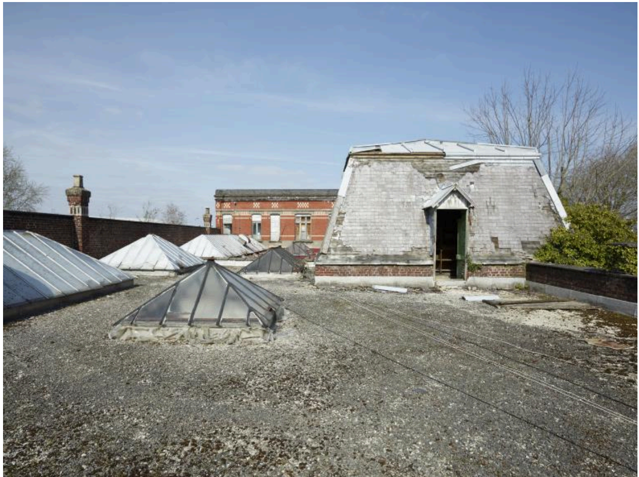
Bureaux. Couvrement. Vue prise vers l'est.
