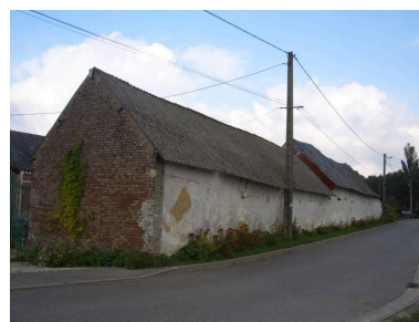
Vue des bâtiments sur rue depuis l'ouest. Phot. Inès Guérin IVR22_20068005442NUCA
