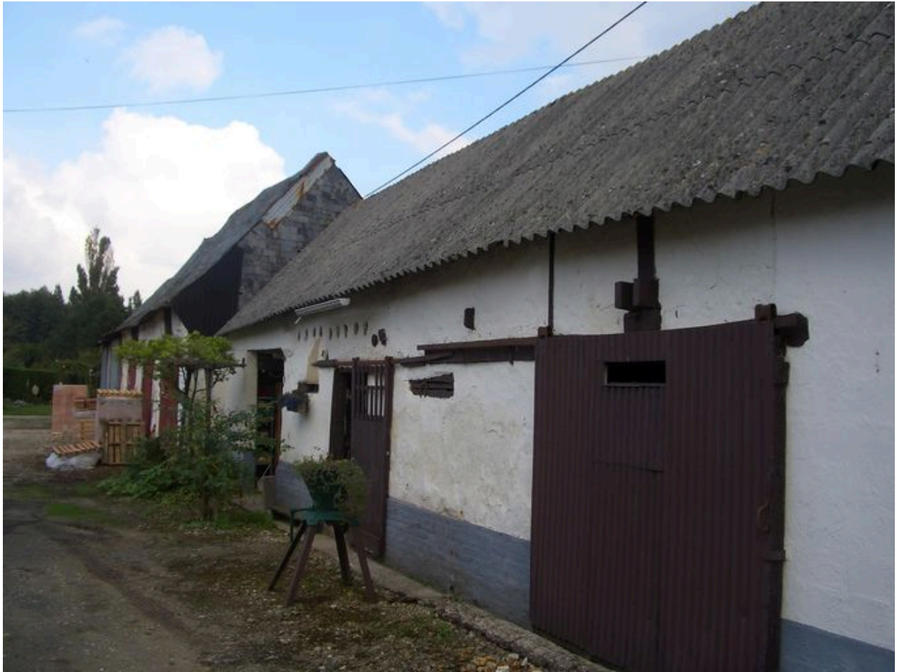
Vue des étables depuis la cour.
