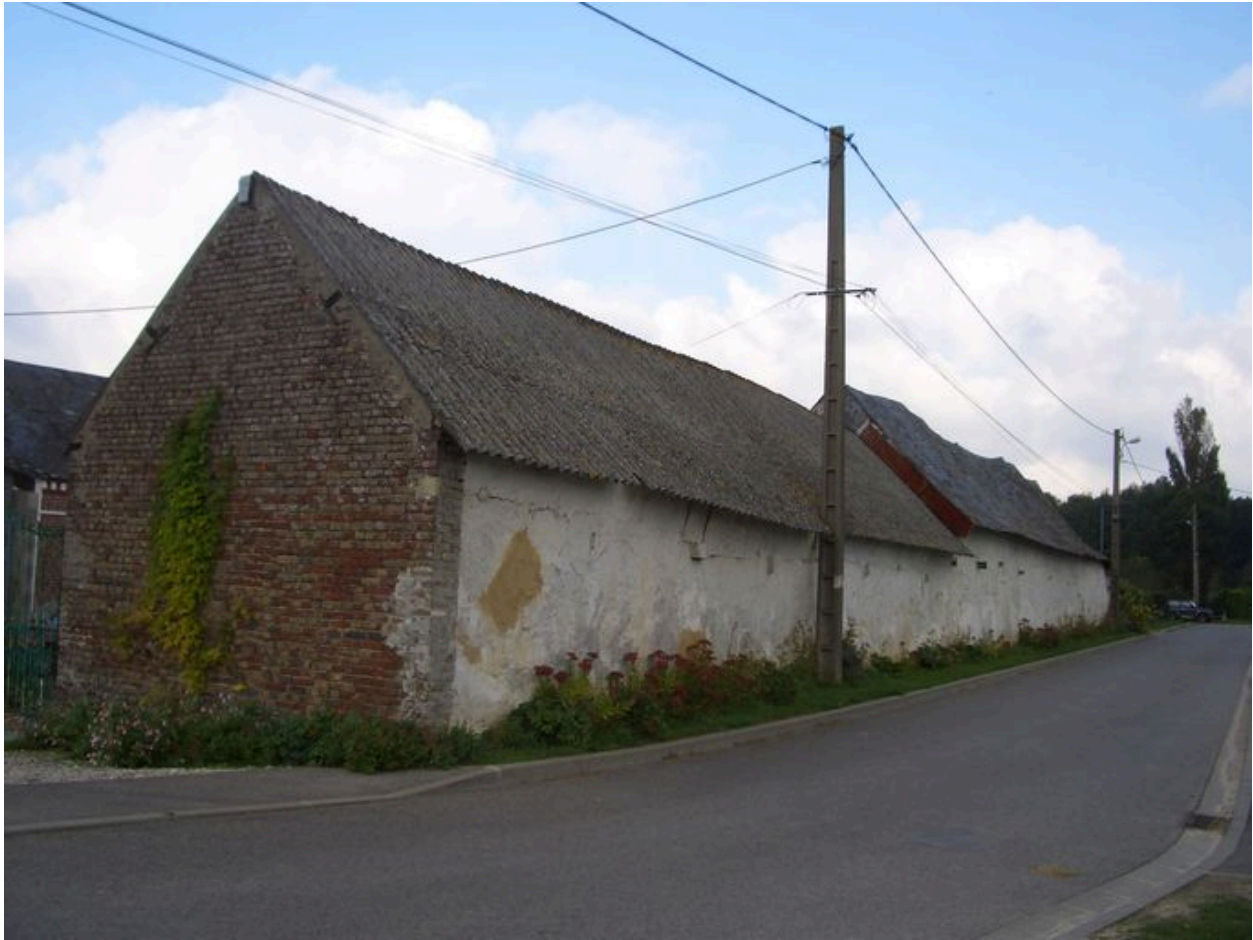
Vue des bâtiments sur rue depuis l'ouest.
