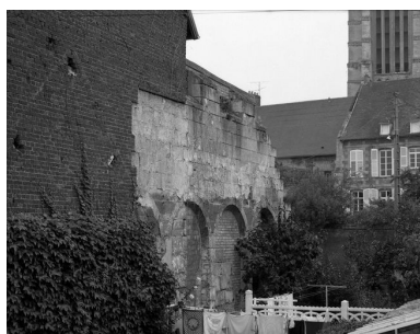
Vestiges du mur gouttereau nord. Phot. Fabrice Charrondière IVR22_19856001374X
