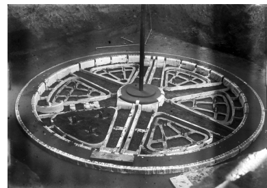
Préparation d'un moule pour la coulée d'un tambour d'enroulement, vers 1919-1921 (AD Aisne).
