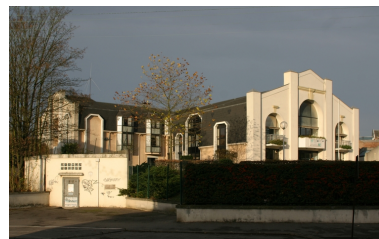
Le site de l'ancienne fonderie de Rocourt.
