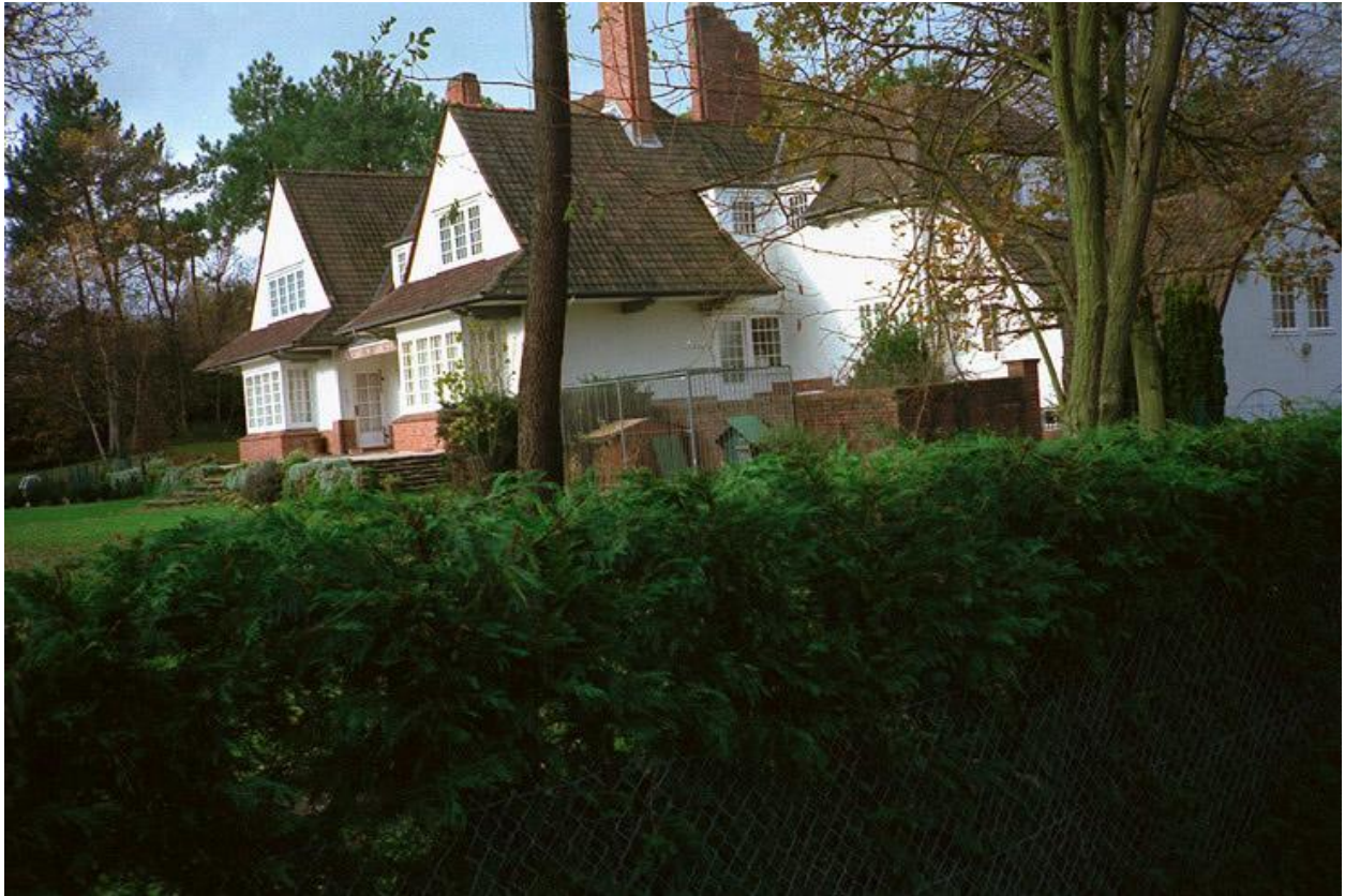
Vue d'ensemble latérale.
