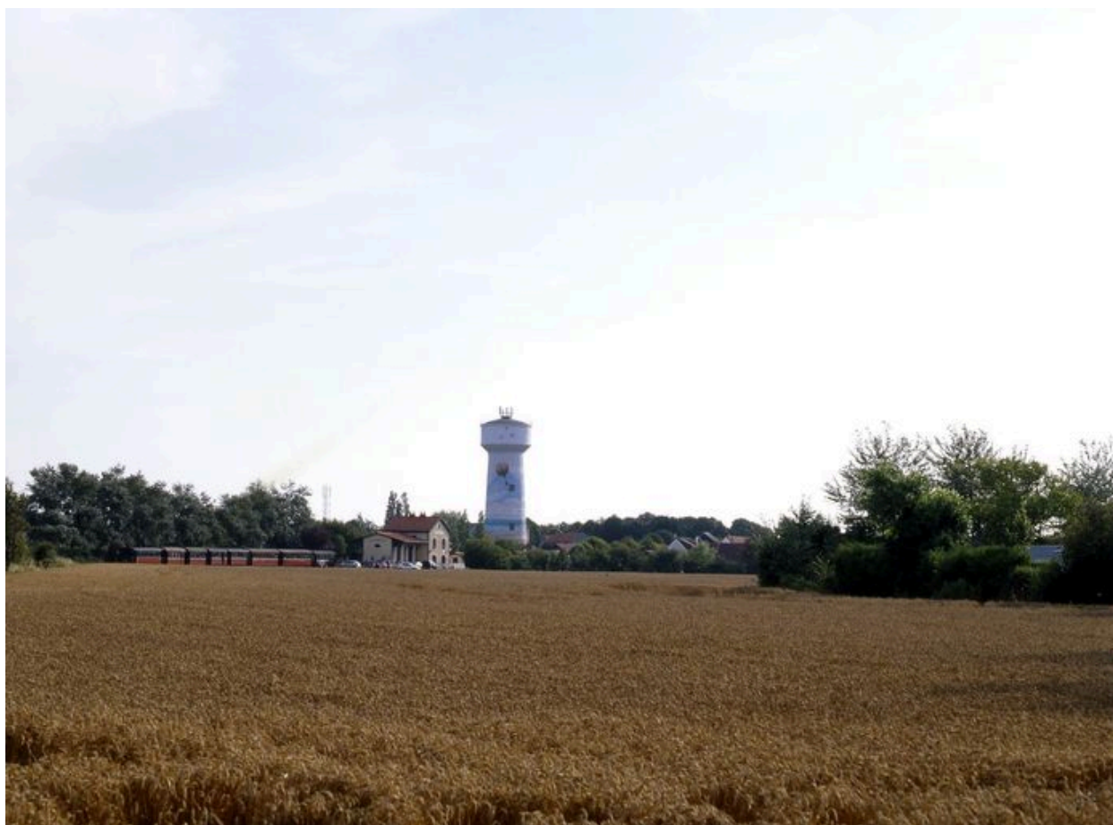
Vue d'ensemble depuis la route D 260.
