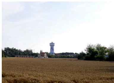
Vue d'ensemble depuis la route D 260.
