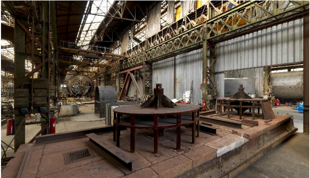
Atelier de chaudronnerie, vue d'ensemble vers l'ouest.
