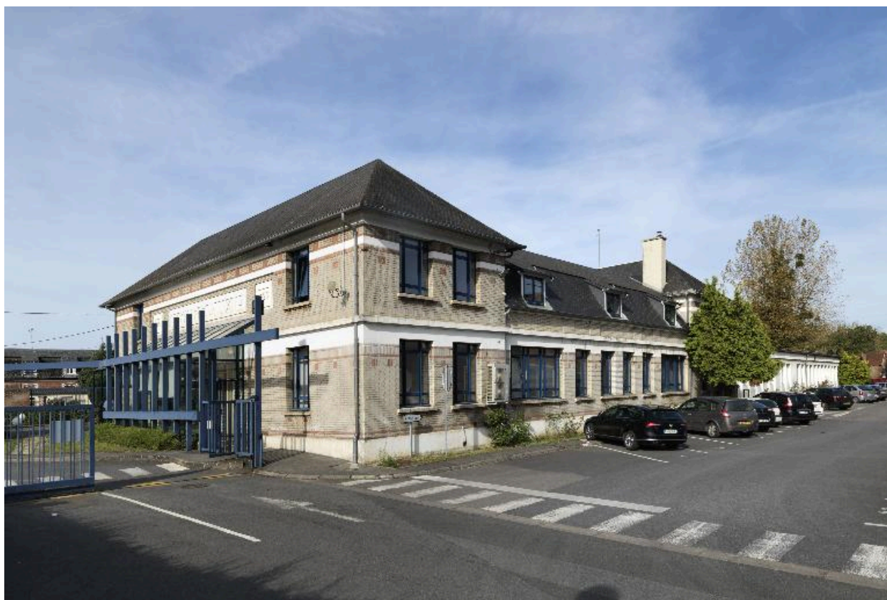
Les bureaux de l'usine, vue de trois-quarts.
