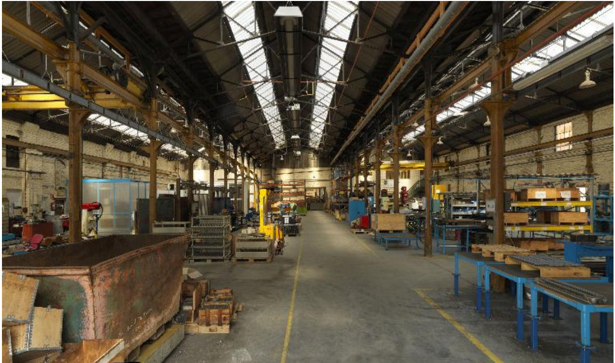
Vue d'ensemble intérieure de l'atelier de mécanique.
