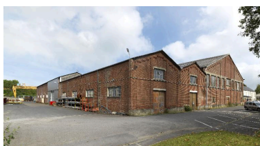
Atelier de mécanique et de chaudronnerie, vue d'ensemble sud-ouest. Phot. Thierry Lefébure IVR32_20160200153NUC2A
