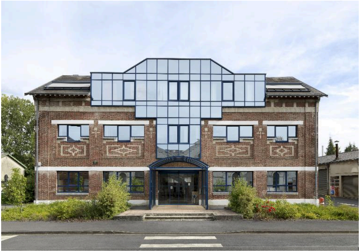
Bâtiment administratif, vue de face.
