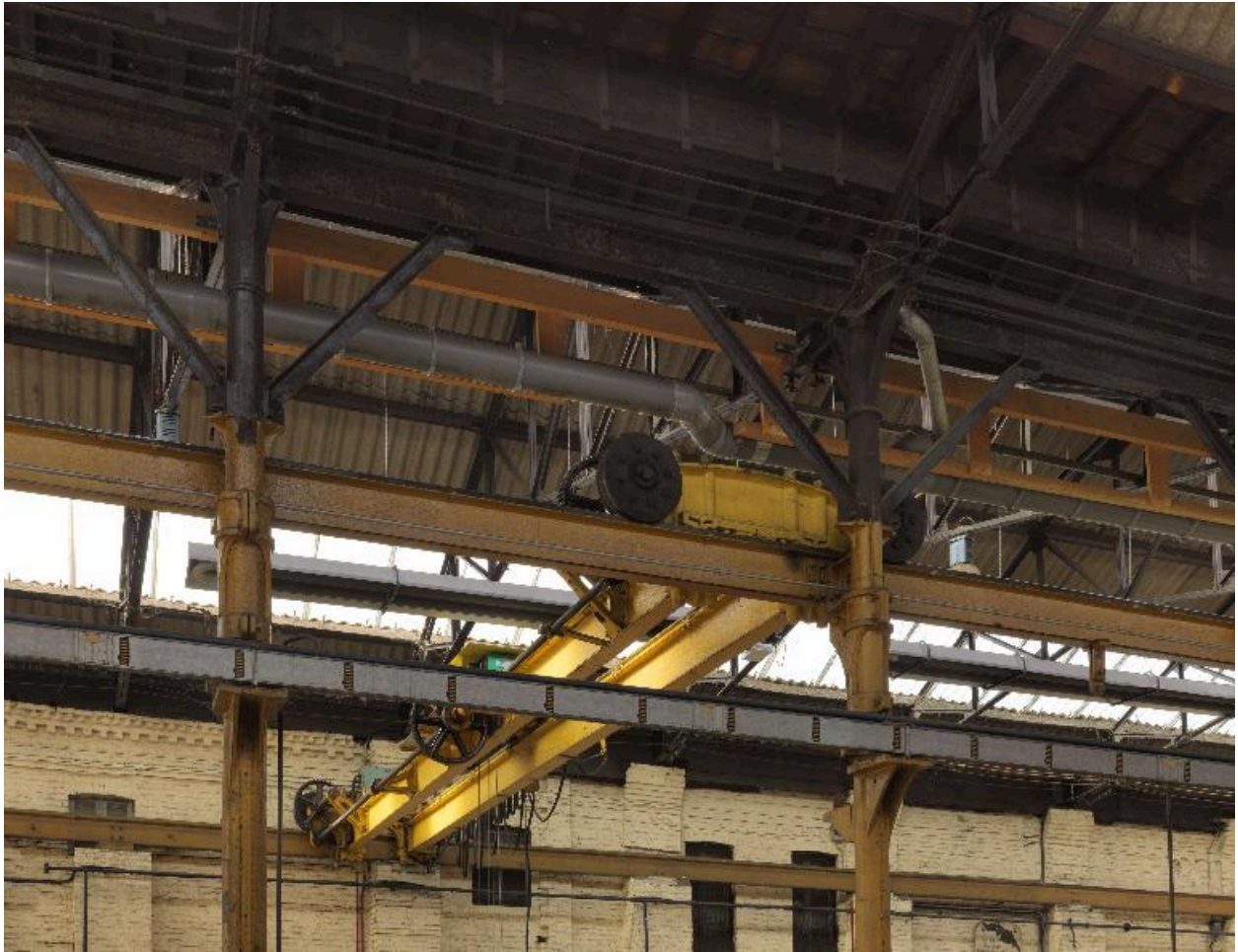
Vue intérieure de l'atelier de mécanique, détail d'un support de la charpente métallique.
