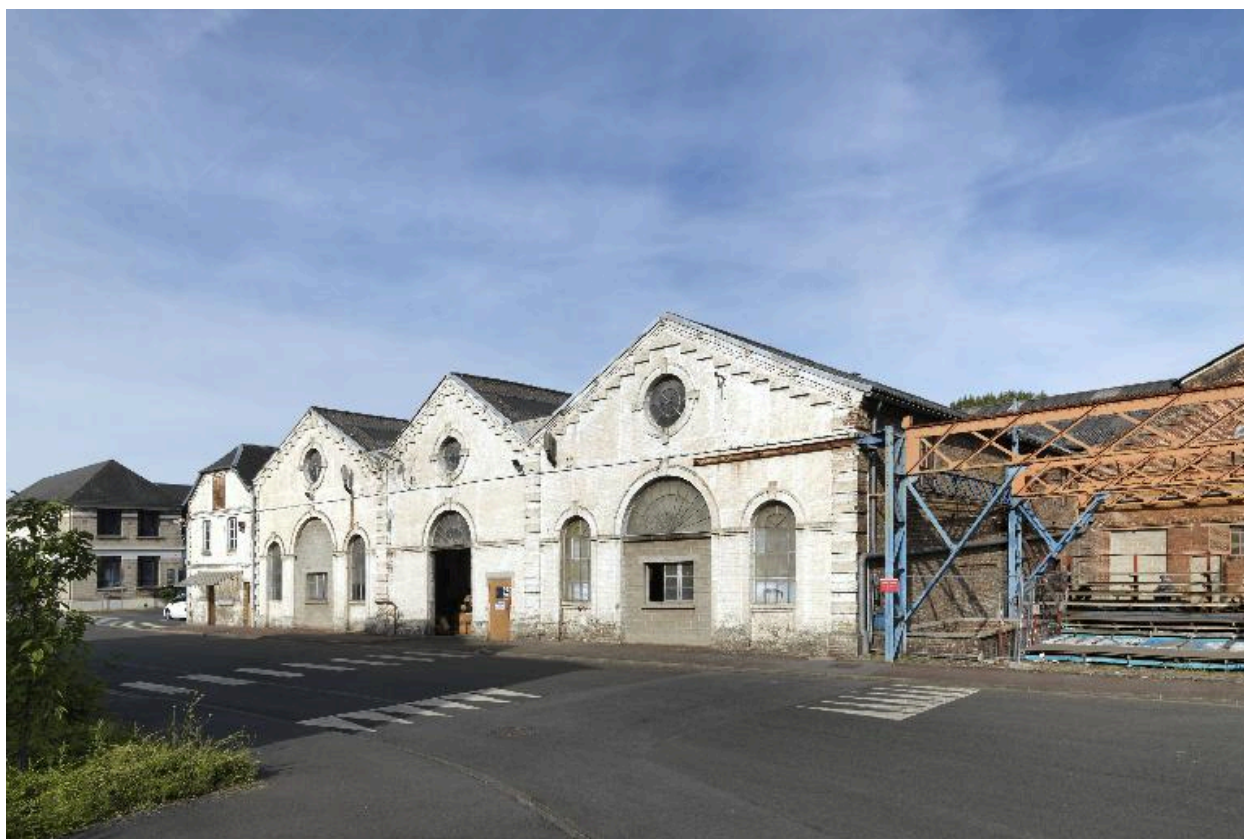
L'atelier de mécanique, vue d'ensemble est.
