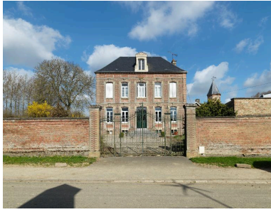
Vue d'ensemble depuis la rue. Phot. Thierry Lefébure IVR22_20138000090NUC2A
