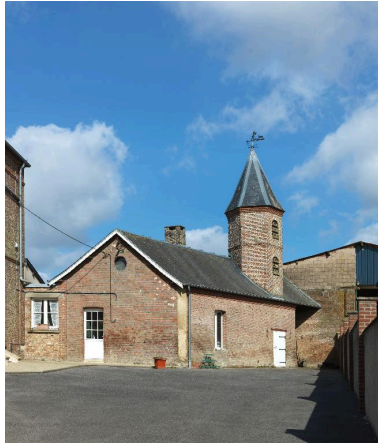
Vue de l'ancienne remise agricole et de son pigeonnier. Phot. Thierry Lefébure IVR22_20138000091NUC2A
