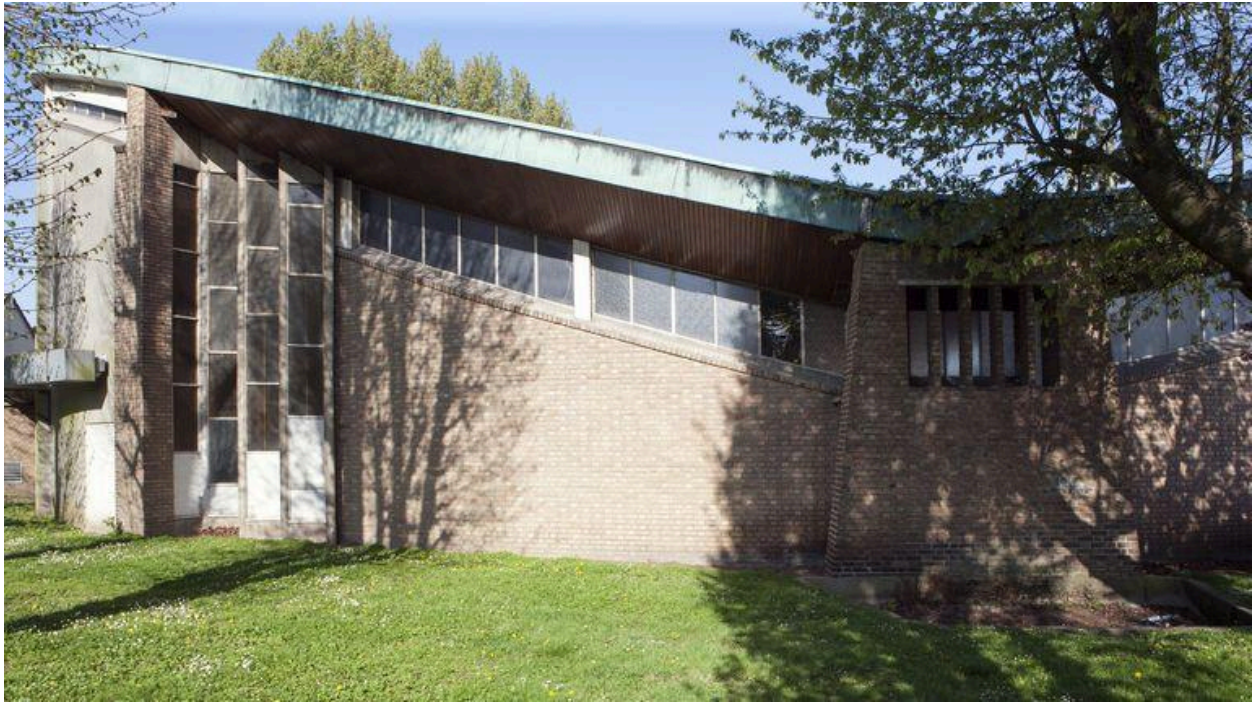
Vue générale du flanc gauche.
