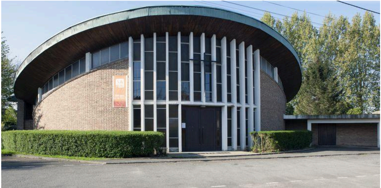
Élévation antérieure de trois quart gauche.
