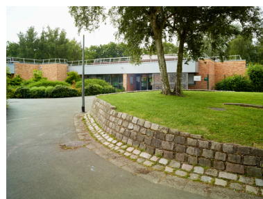
L'école élémentaire depuis le chemin du Triolo. Phot. Pierre Thibaut IVR32_20185900535NUCA
