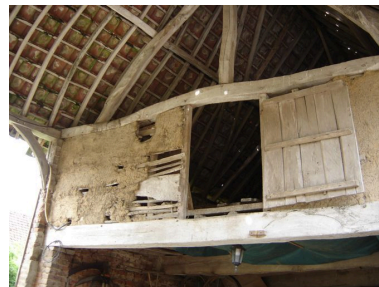
Vue d'une des deux gerbières sous le passage couvert. Phot. Inès Guérin IVR22_20058005935NUCA
