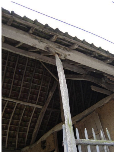
Vue détaillée du système de fixation du portail. Phot. Inès Guérin IVR22_20058005934NUCA
