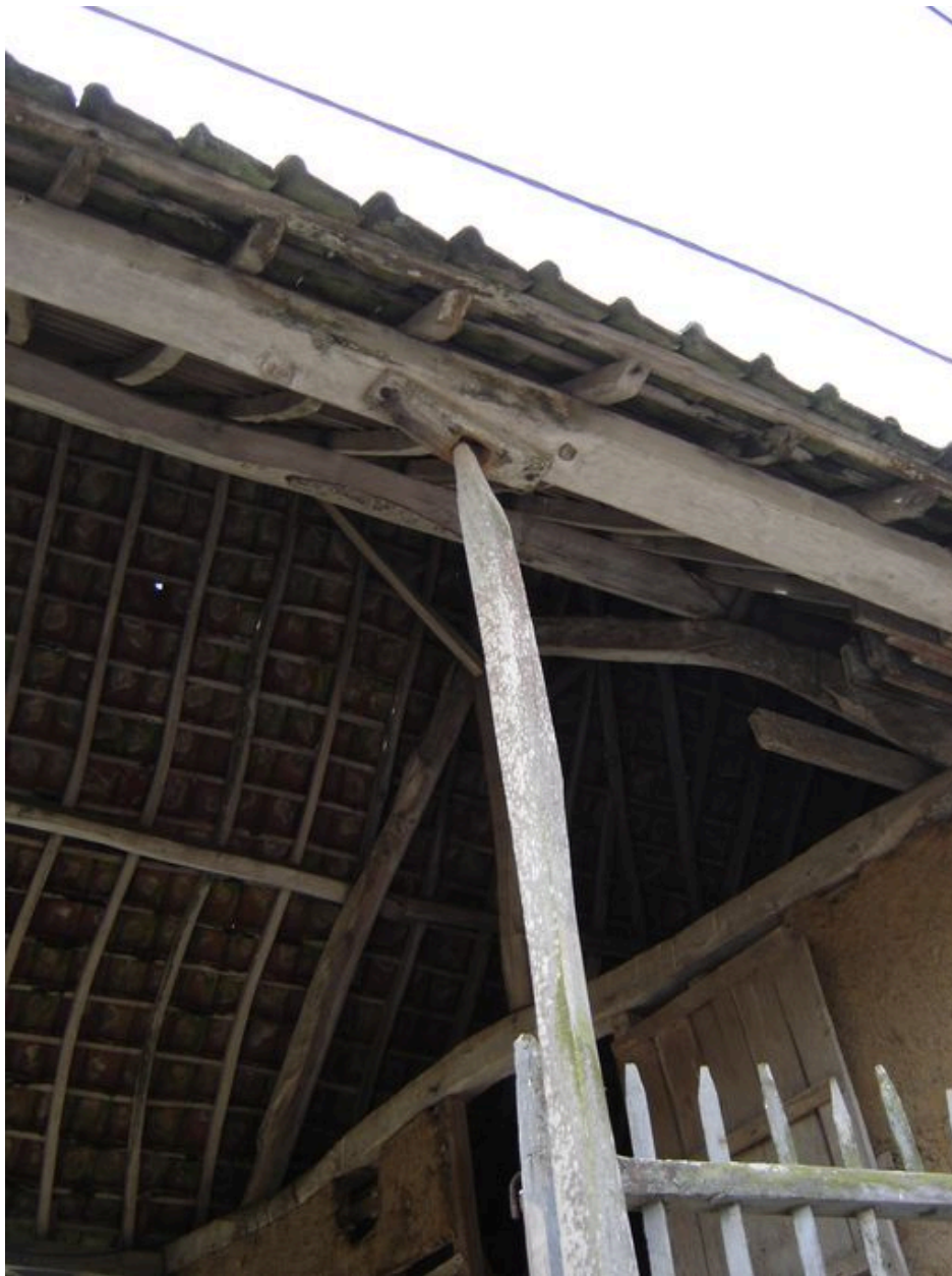
Vue détaillée du système de fixation du portail.
