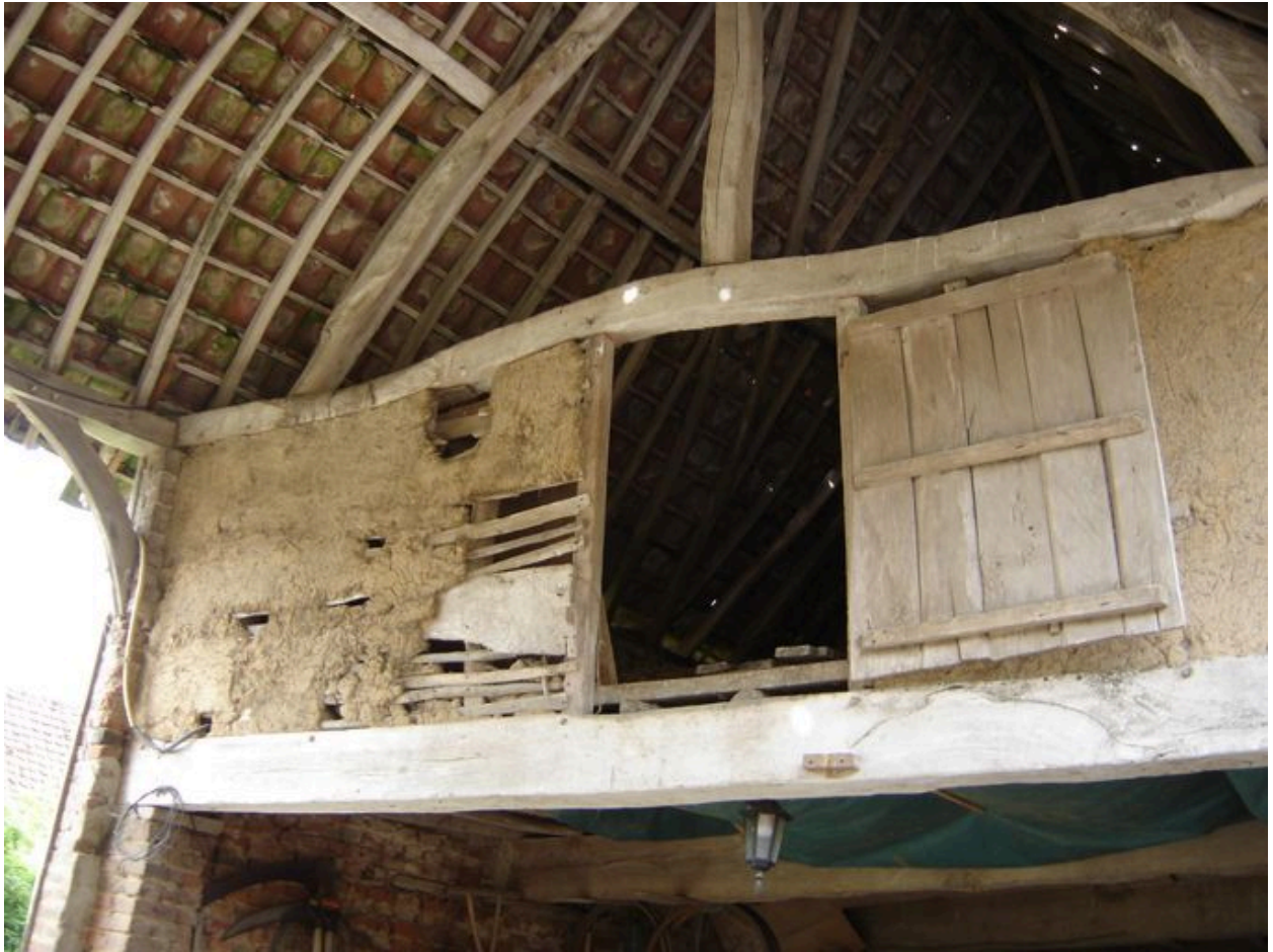
Vue d'une des deux gerbières sous le passage couvert.
