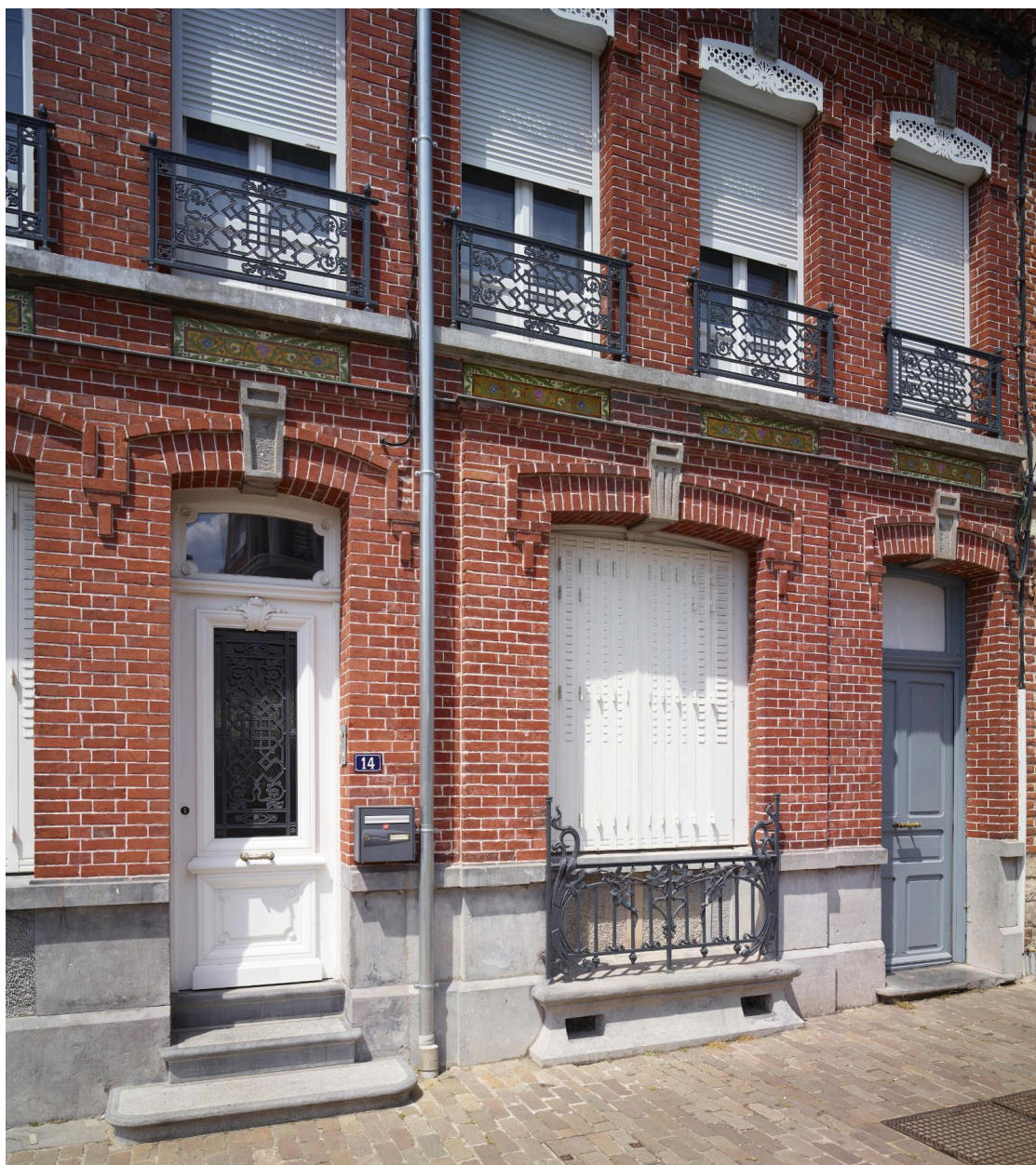
Détail des deux portes d'entrée. Vue de face.
