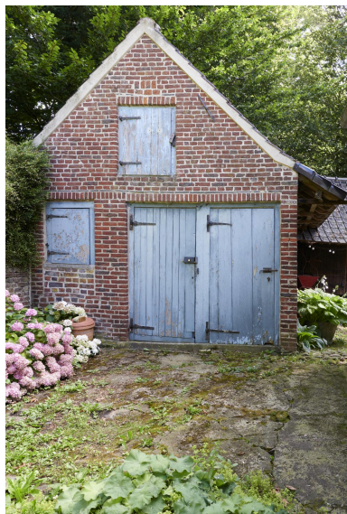
Ancien lavoir, pignon ouest. Phot. Delphine Volto Jourdan IVR32_20245902815NUCA
