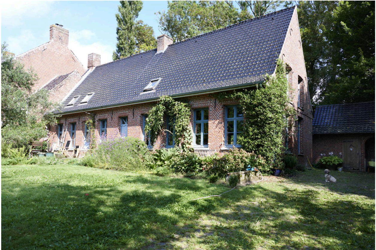
Façade principale sud et pignon est.
