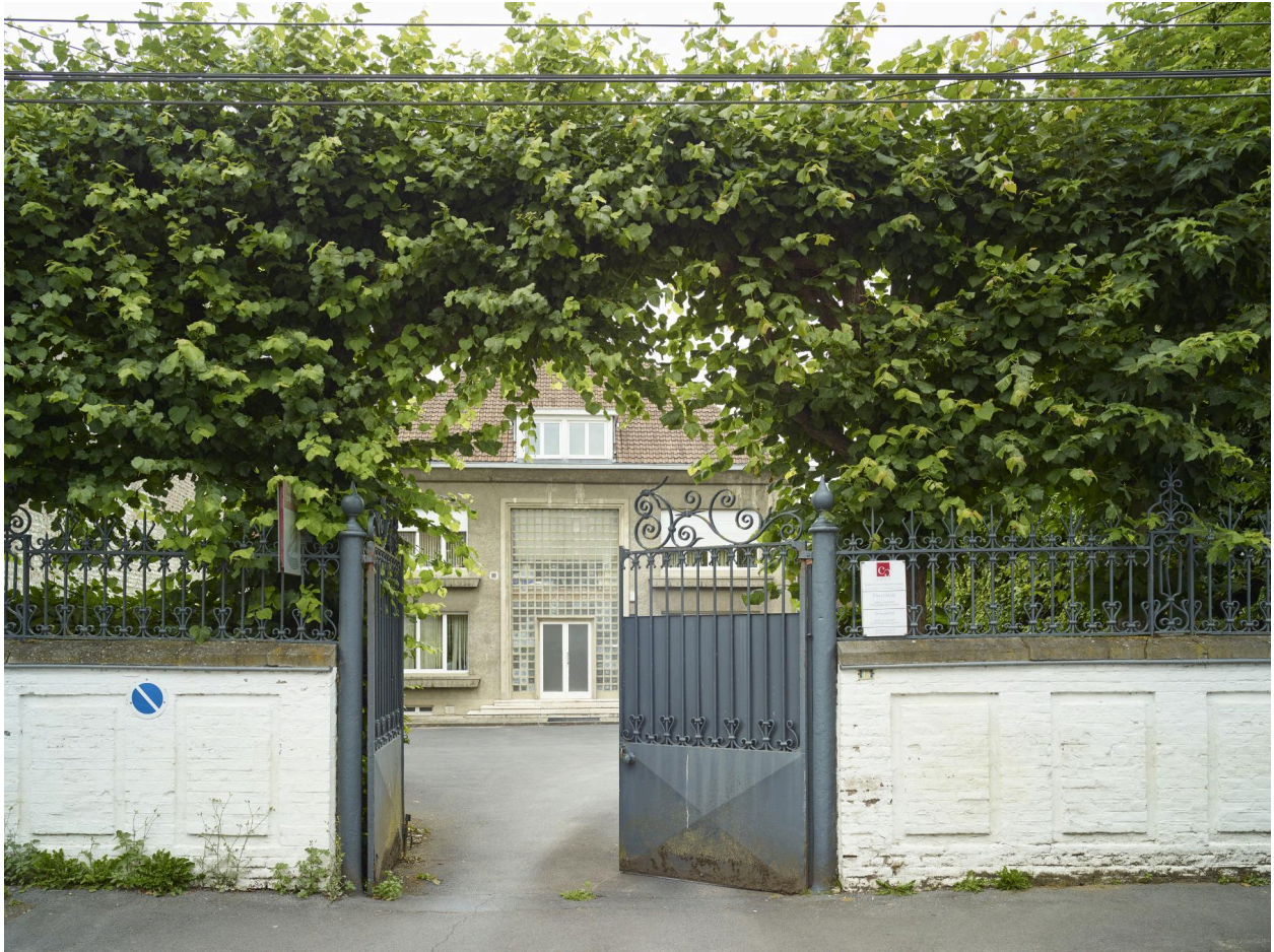
Maison, 14 rue Achille Carlier : vue générale, avec le mur bahut qui ferme la parcelle sur la rue.
