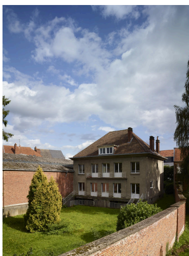
Maison, 14 rue Achille Carlier : vue générale de la façade arrière. Phot. Pierre Thibaut IVR32_20245900304NUCA
