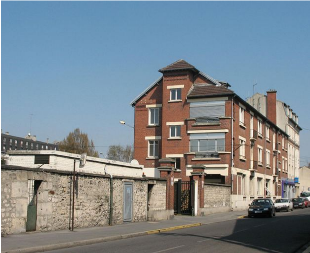
Logements et bureaux de l'usine.
