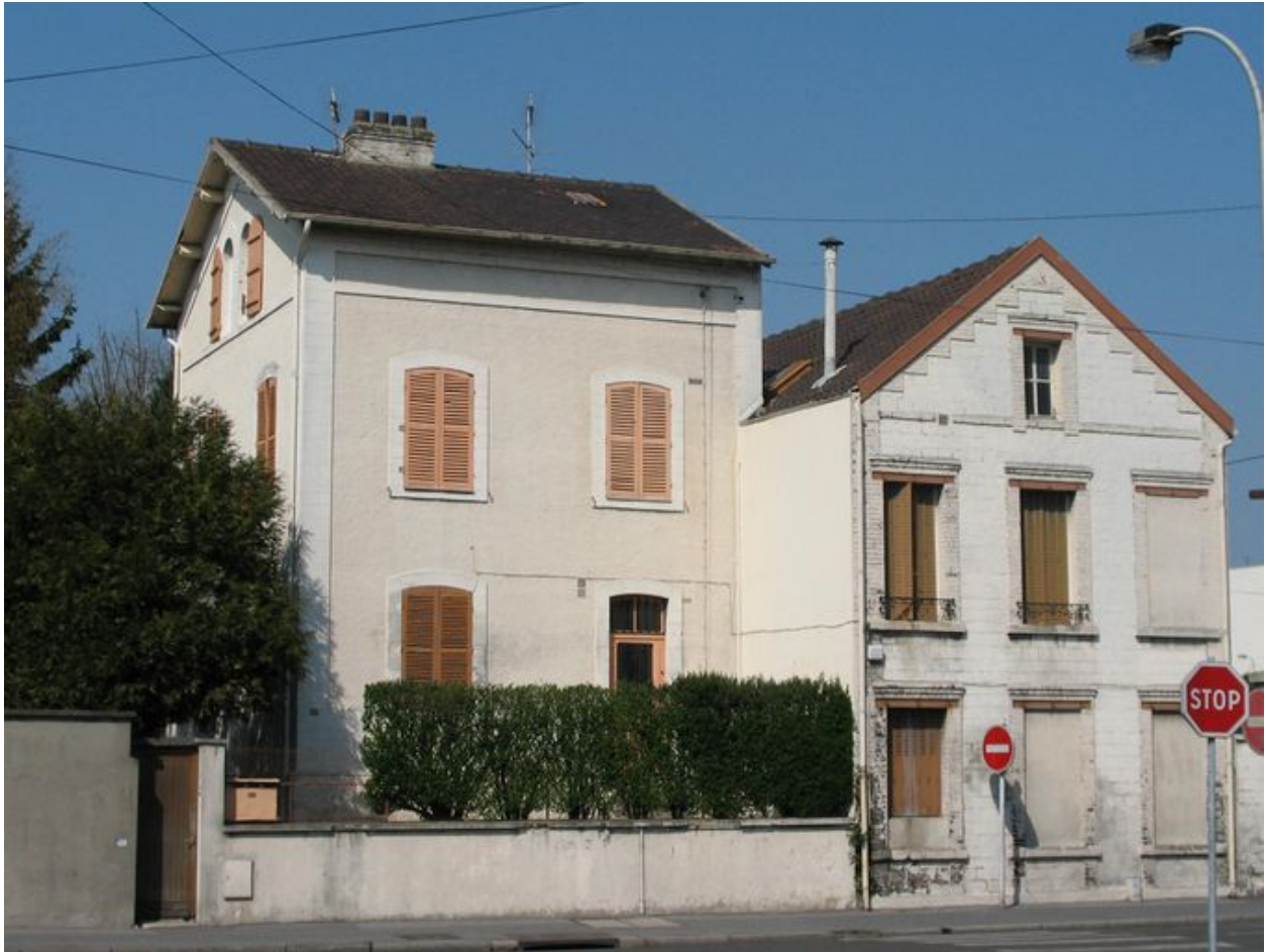
Ancienne maison du sous-chef de gare à gauche et magasins de l'usine à gaz à droite.
