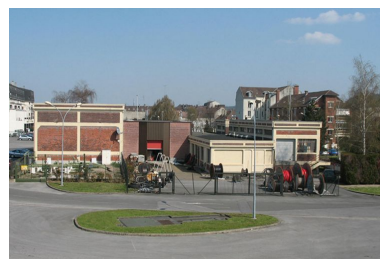
Les anciens ateliers de fabrication. Phot. Clarisse Lorieux IVR22_20076005245NUCA
