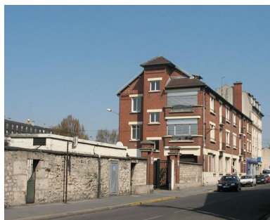
Logements et bureaux de l'usine. Phot. Clarisse Lorieux IVR22_20076005246NUCA
