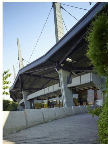
La rampe d'accès et l'entrée. Phot. Pierre Thibaut IVR32_20185900053NUCA
