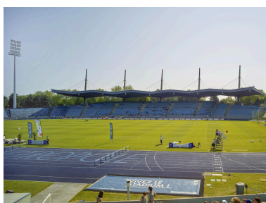
Les gradins, la tribune est et le terrain depuis l'ouest. Phot. Pierre Thibaut IVR32_20185900051NUCA
