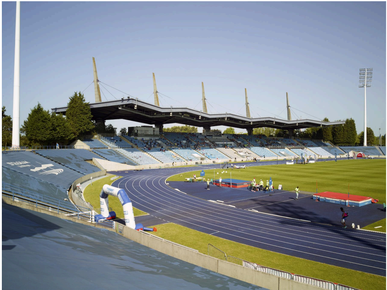
Vue de la tribune et des gradins ouest depuis le sud.
