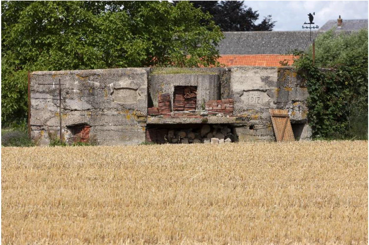
Elévation antérieure vers le nord-ouest
