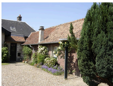
Vue des dépendances. Phot. Inès Guérin IVR22_20058005888NUCA
