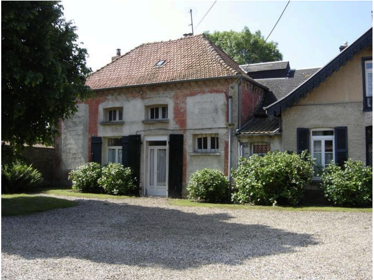
Vue du logis situé au n°53.
