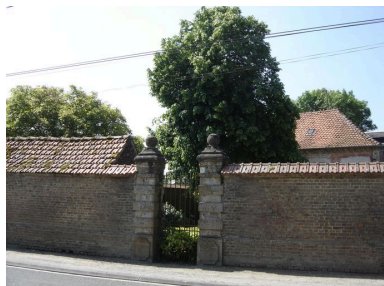
Vue du mur de clôture et de la porte d'accès du n°53. Phot. Inès Guérin IVR22_20058005884NUCA
