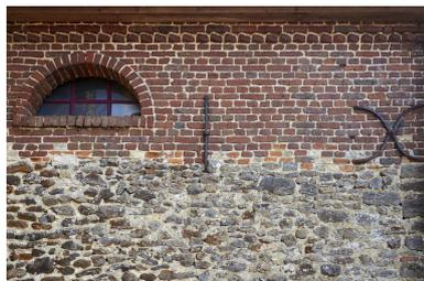
Bas-côté nord de l'avant porche de l'église. Fer d'ancrage en ancre droite, soubassement en grès de Cassel, briques.
