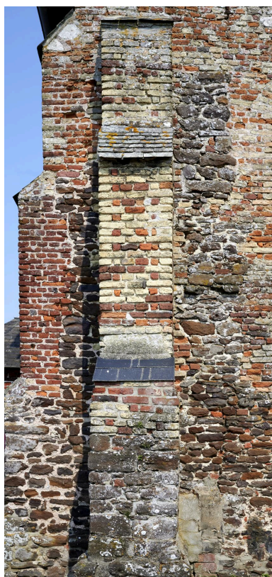
Façade de l'église. Contreforts. Phot. Delphine Volto Jourdan IVR32_20235900665NUCA
