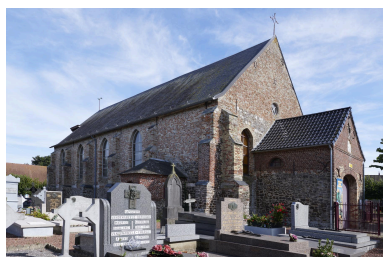
Vue générale de l'église depuis le nord-ouest. Phot. Delphine Volto Jourdan IVR32_20235901238NUCA
