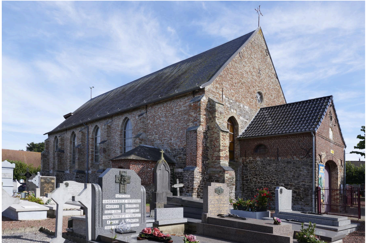
Vue générale de l'église depuis le nord-ouest.
