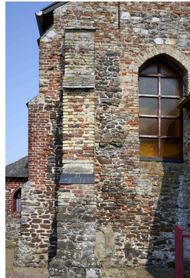
Détail de la façade. Contreforts, matériaux. Phot. Delphine Volto Jourdan IVR32_20235900666NUCA
