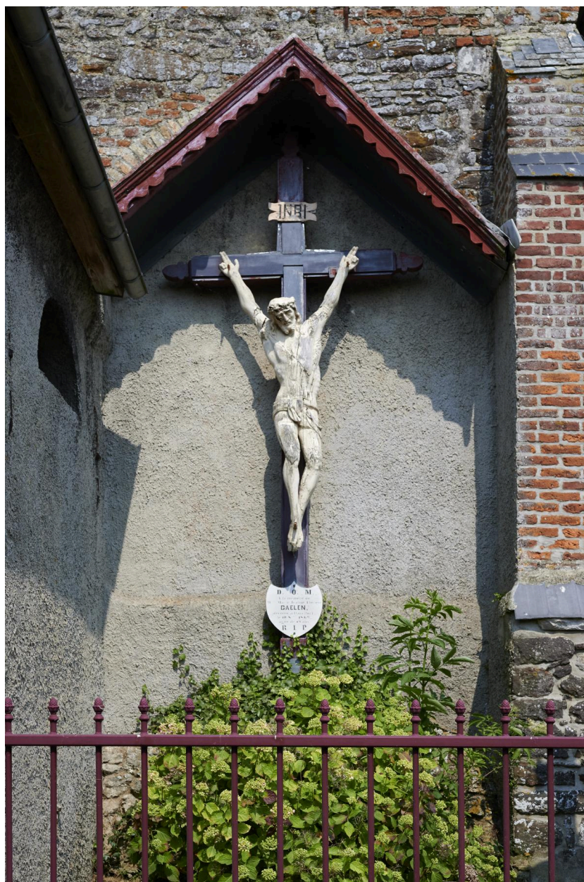
Calvaire adossé au mur de l'église. Bas-côté sud.
