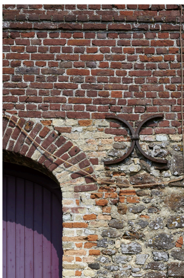
Détail d'un fer d'ancrage en "X" de l'église. Matériaux : brique et grès de Cassel. Phot. Delphine Volto Jourdan IVR32_20235900669NUCA
