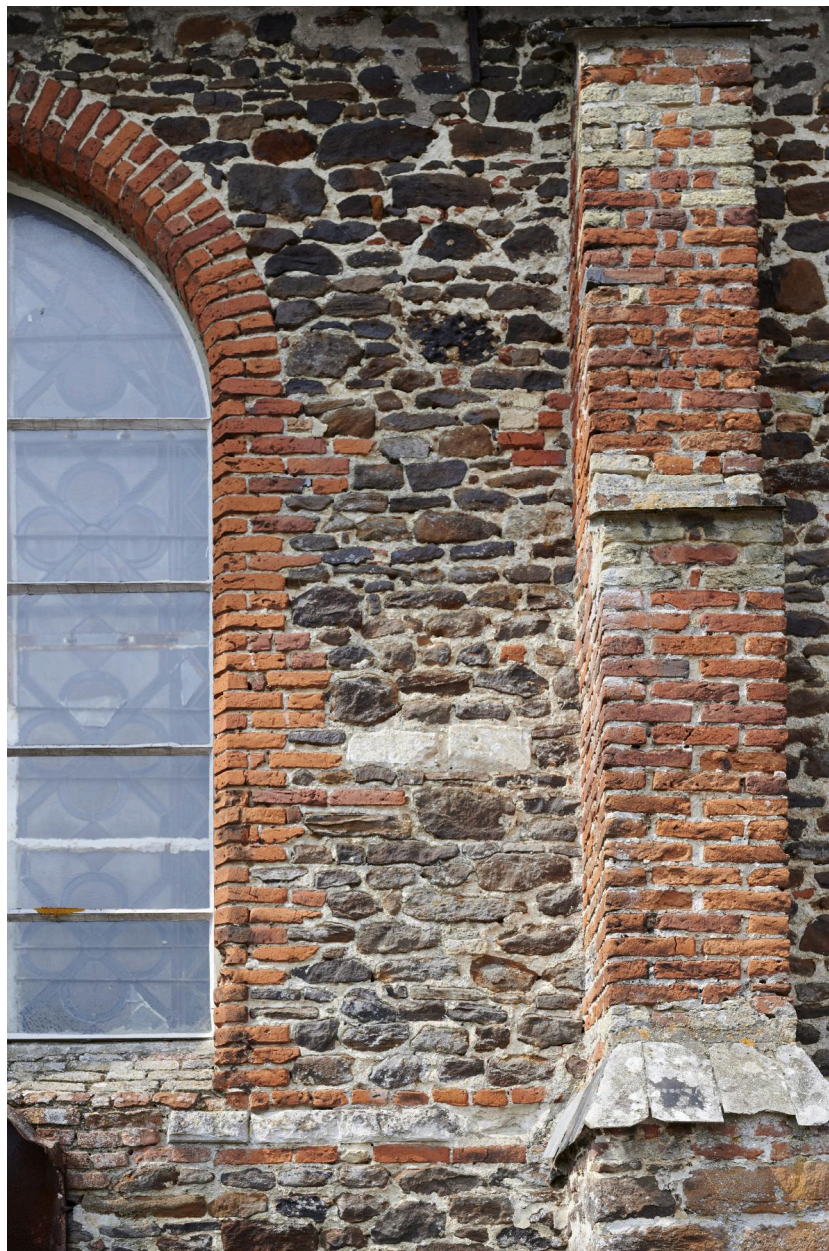
Détail d'un contrefort du bas-côté sud. Baie.
