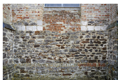
Détail d'une travée composée de différents matériaux : grès, blocs calcaire, briques, ardoises. Phot. Delphine Volto Jourdan IVR32_20235900663NUCA
