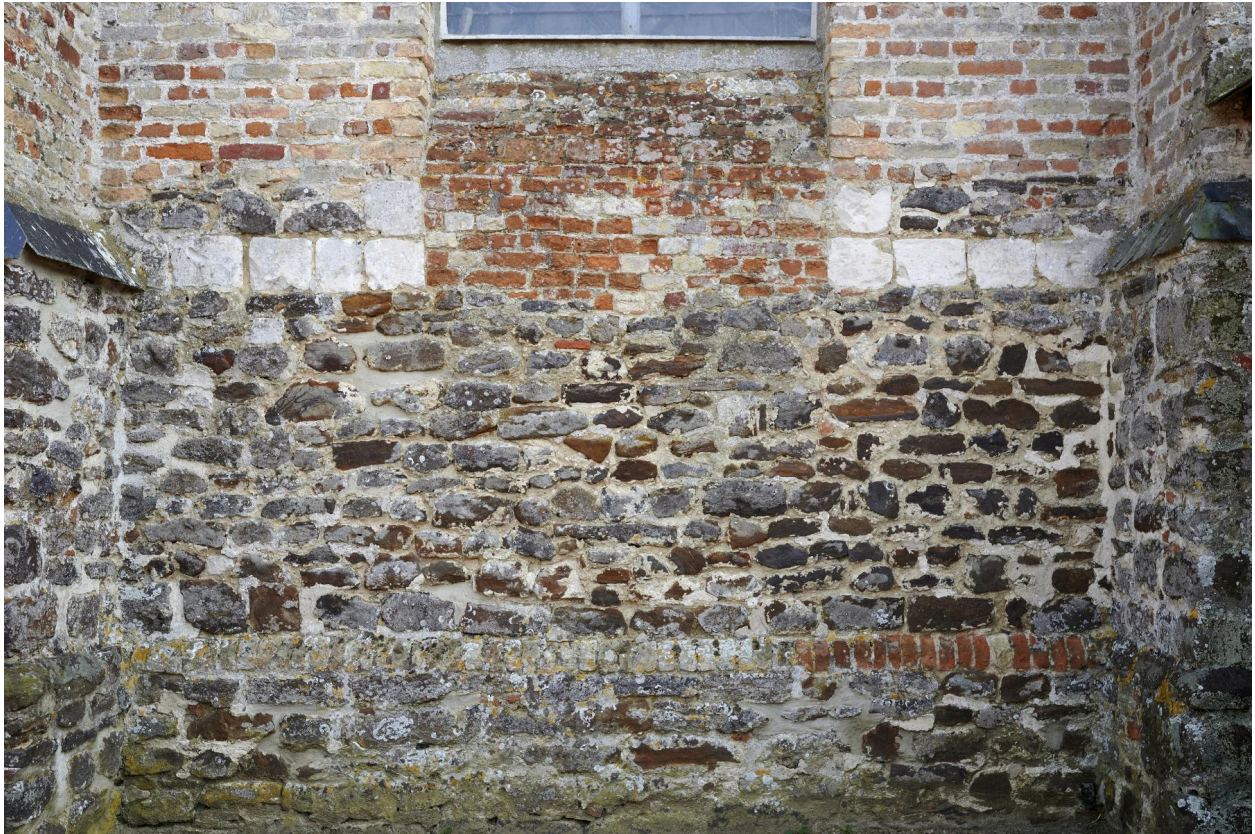
Détail d'une travée composée de différents matériaux : grès, blocs calcaire, briques, ardoises.
