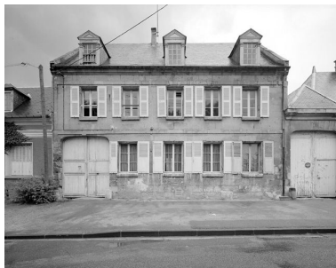
Elévation antérieure. Phot. Jean-Michel Perrin IVR22_19856000822V
