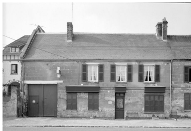
Elévation antérieure. Phot. Jean-Michel Perrin IVR22_19856000797X
