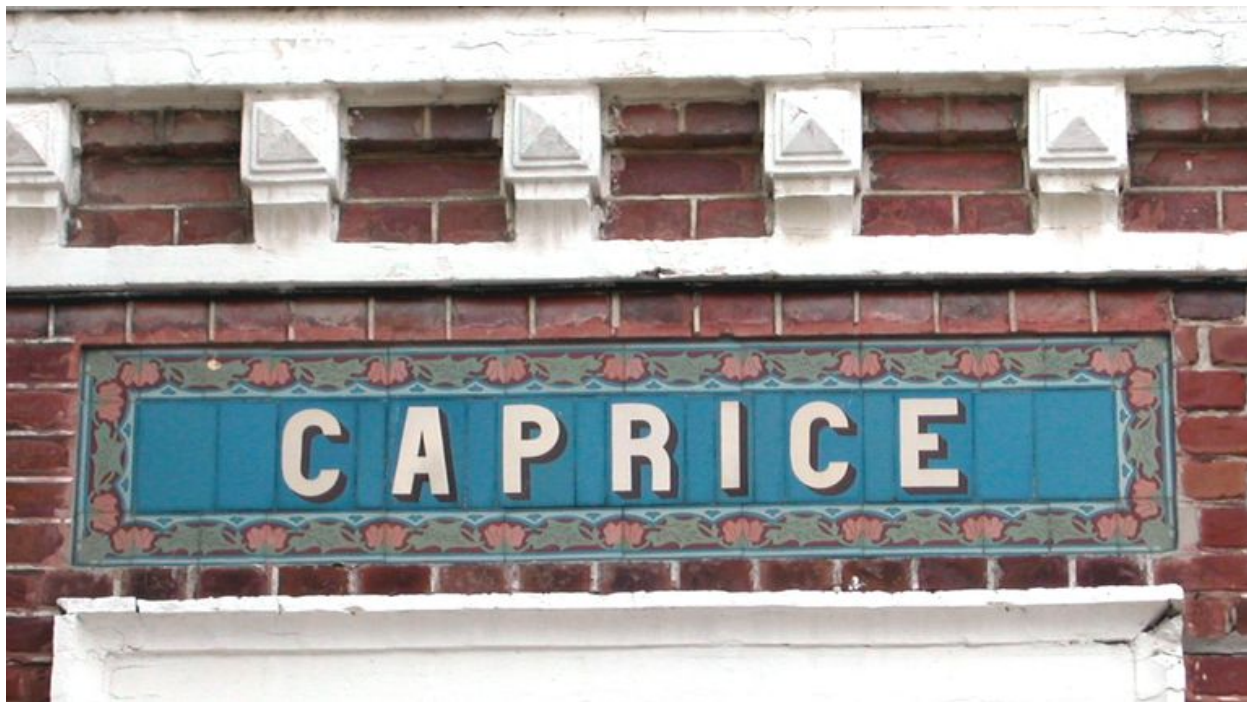
Détail des carreaux de céramique portant appellation.
