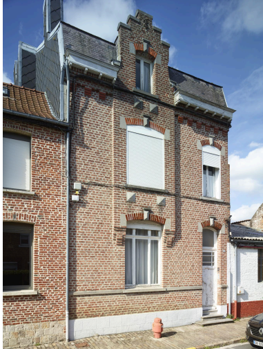
Maison - 32, rue Baillon : maison réhaussée présentant une façade Art déco. IVR32_20245900401NUCA
