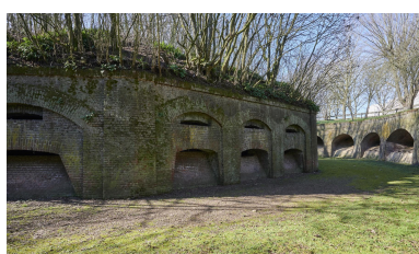
La caponnière double, vers l'ouest. Phot. Pierre Thibaut IVR32_20235900287NUCA
