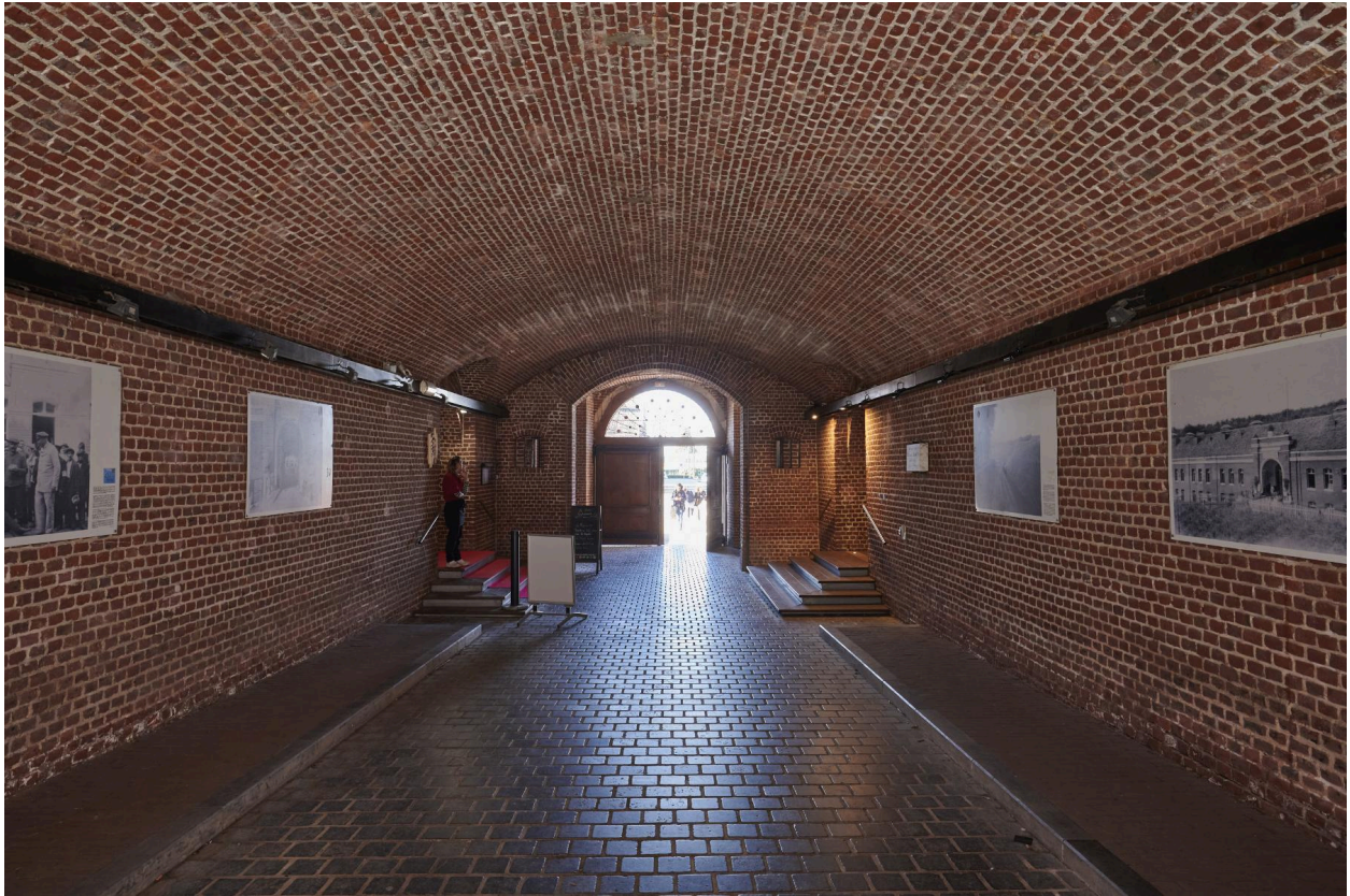
Passage couvert sous la caserne de gorge, vers le pont.
