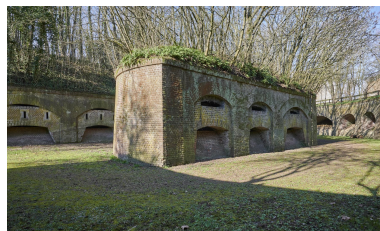
La caponnière double depuis le fossé de tête, vers le nord-ouest. Phot. Pierre Thibaut IVR32_20235900285NUCA
