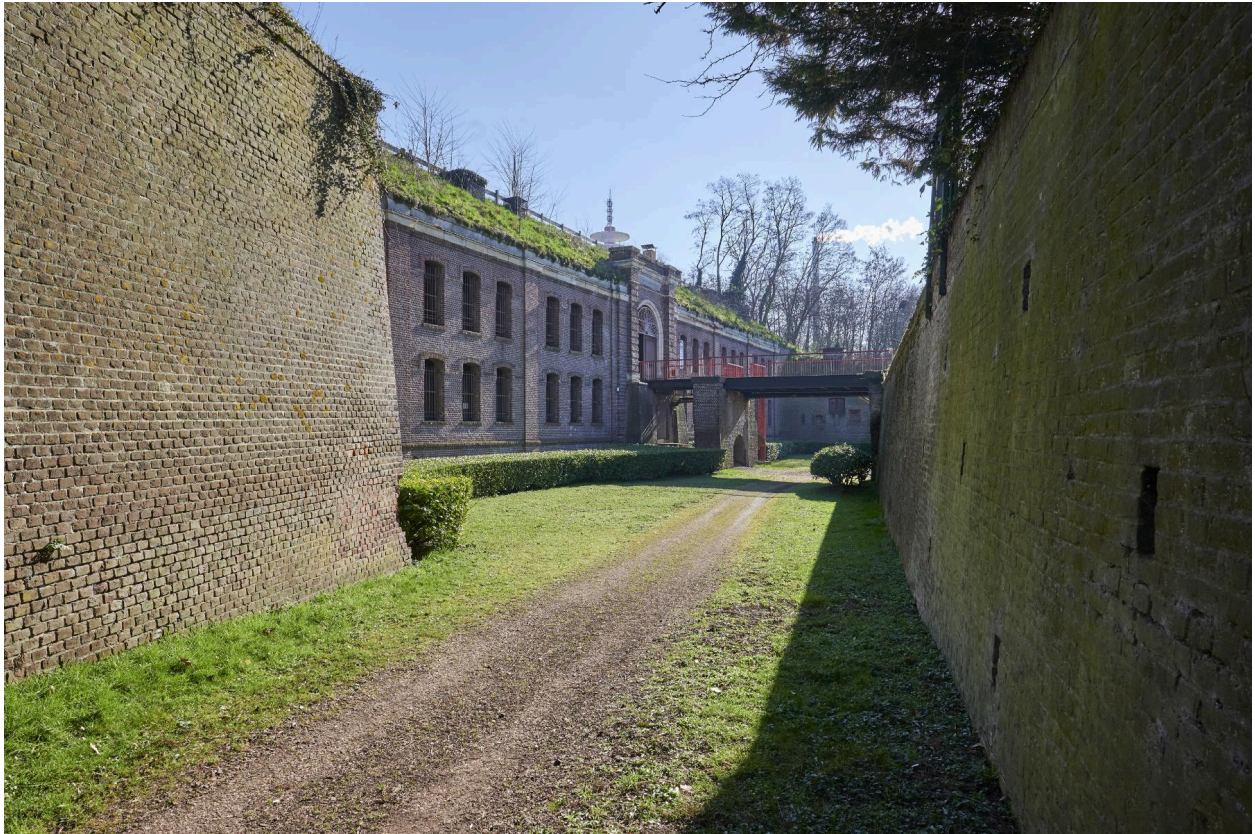
Depuis le fossé de gorge, le pont d'accès au fort.
