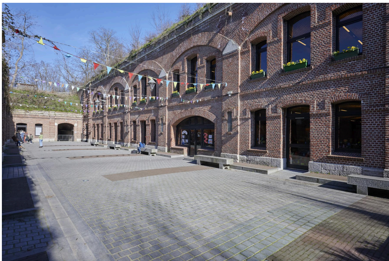
La caserne de tête transformée en médiathèque. Élévation ouest, vers le nord.
