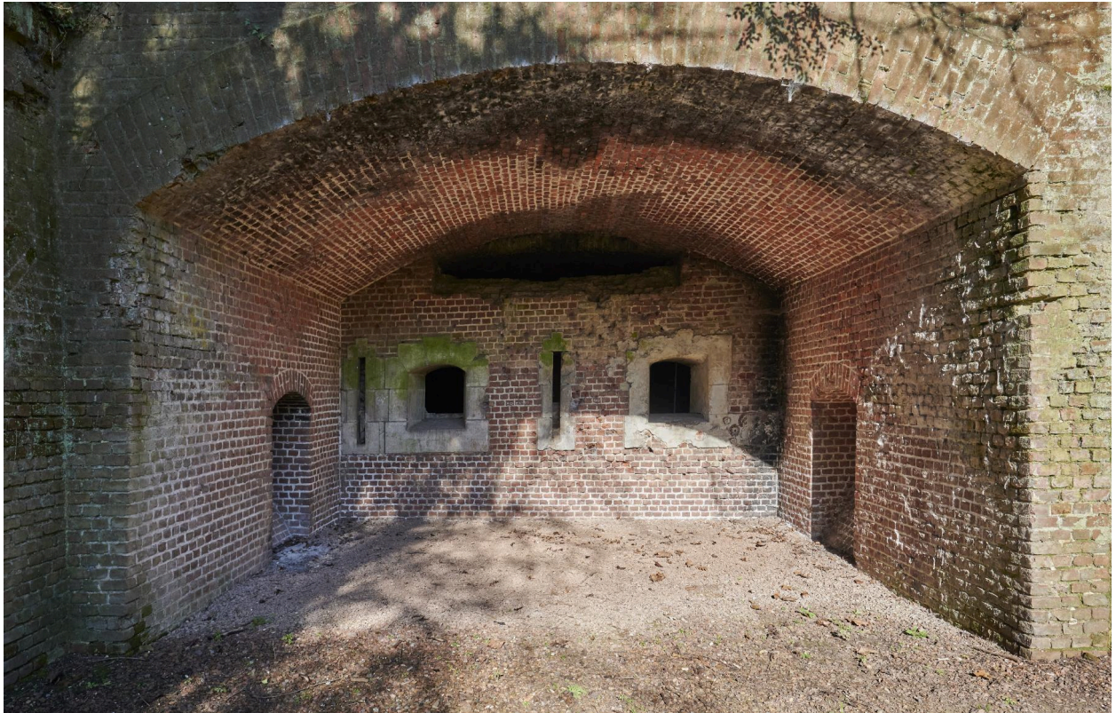
Embrasures de tir de la caponnière double battant le fossé de tête.
