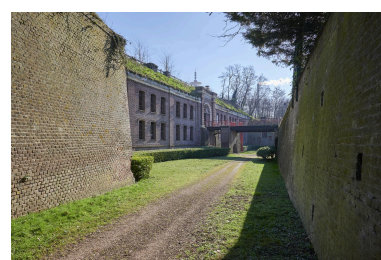
Depuis le fossé de gorge, le pont d'accès au fort. Phot. Pierre Thibaut IVR32_20235900289NUCA
