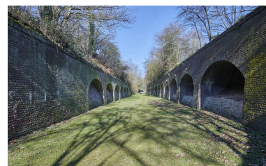
Fossé de tête. Au fond, la caponnière double. Phot. Pierre Thibaut IVR32_20235900282NUCA
