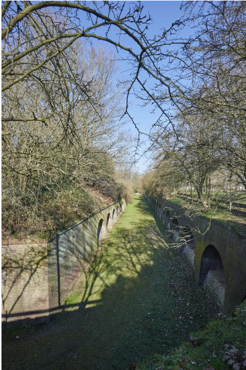
Fossé sud-est depuis la contrescarpe. Au fond la caponnière simple.
