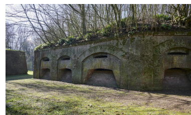
La caponnière double, vers l'est. Phot. Pierre Thibaut IVR32_20235900286NUCA
