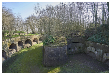
L'orillon de la caponnière double en plongée depuis la contrescarpe, vers l'est. À droite, les créneaux de fusillade ; à gauche, les arcs de décharge de la contrescarpe. Phot. Pierre Thibaut IVR32_20235900276NUCA
