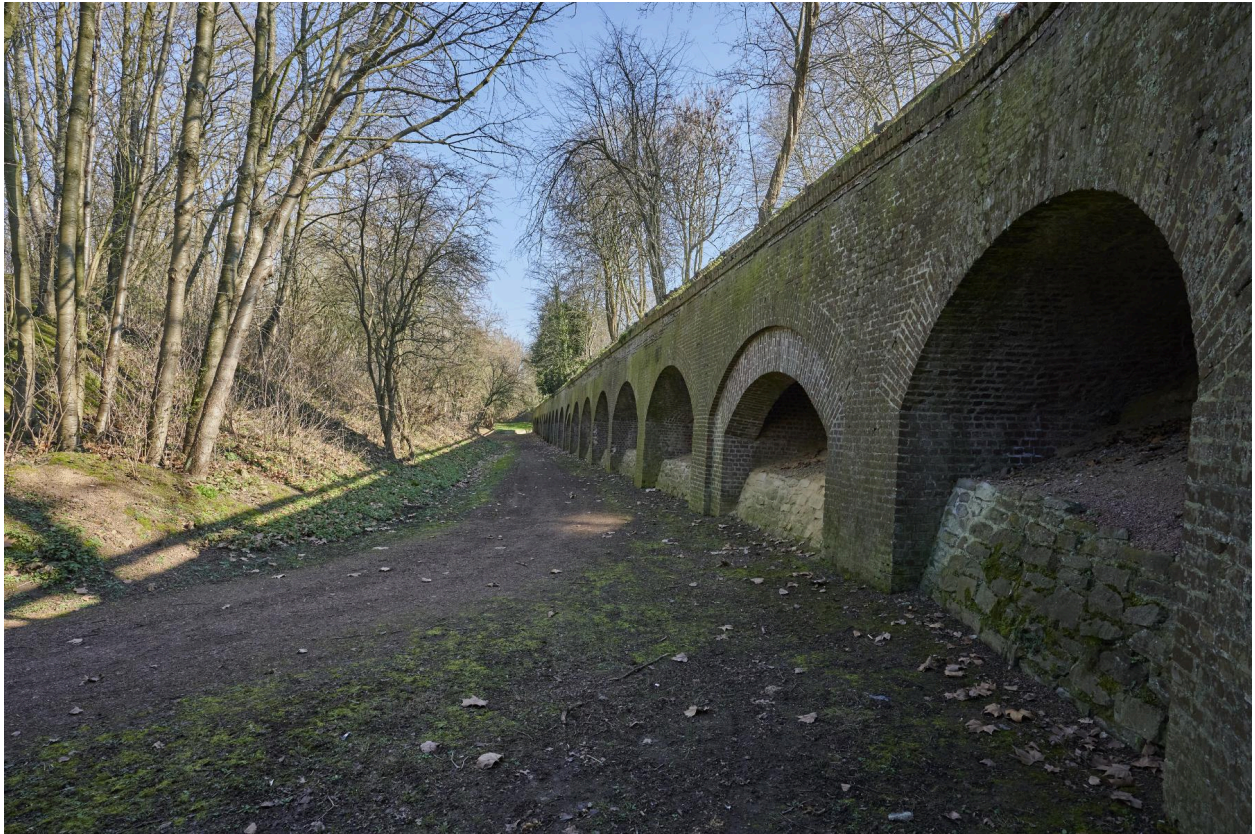
Fossé sud-est. Au fond la caponnière simple.
