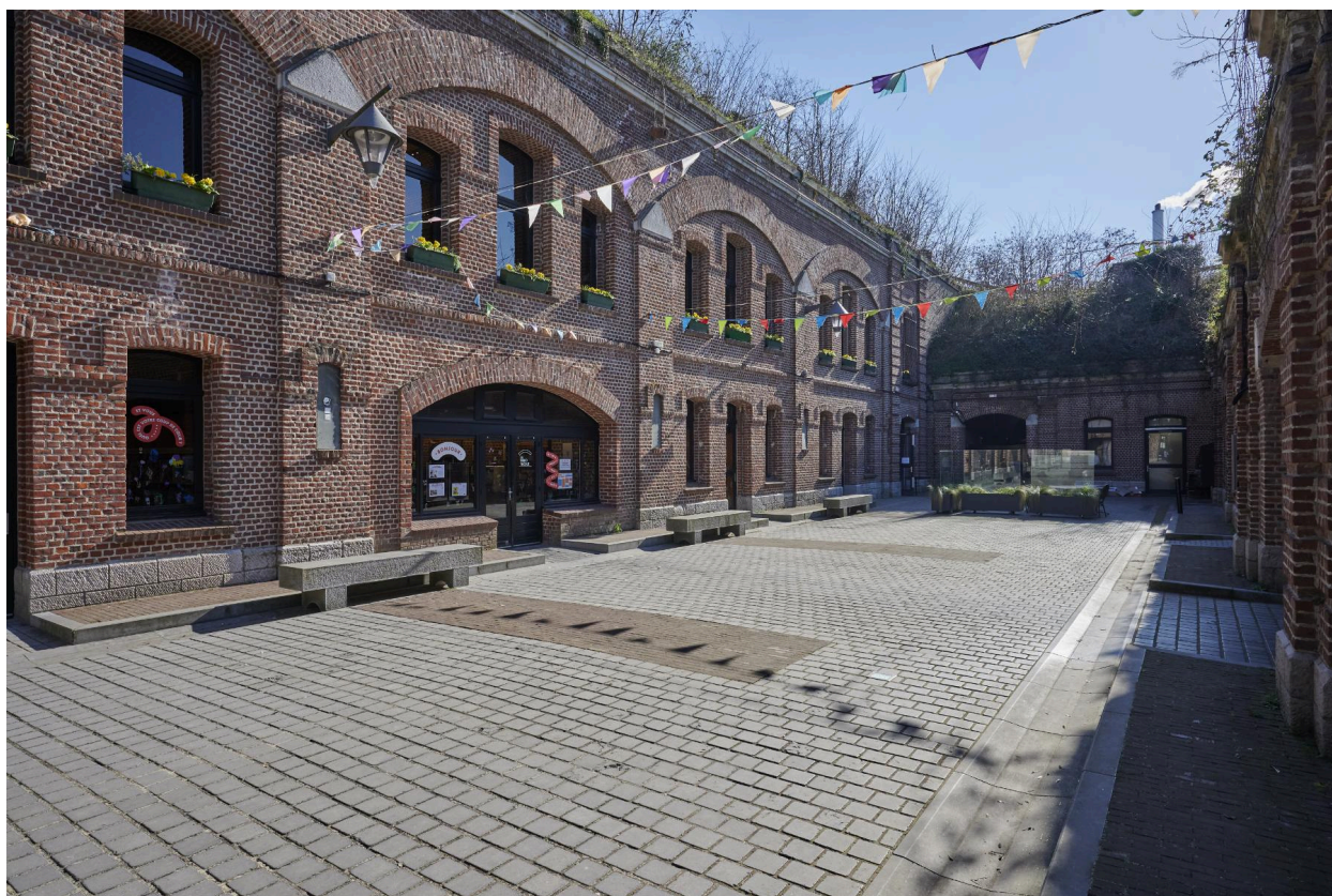
La caserne de tête transformée en médiathèque. Élévation ouest, vers le sud.
