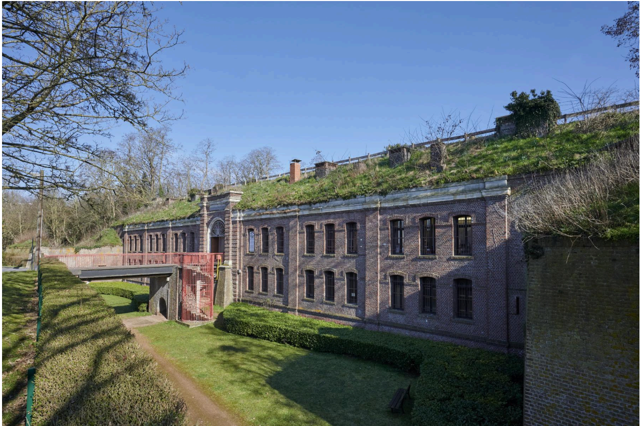
Vue générale vers le nord du pont mobile, de la courtine et de l'élévation ouest de la caserne de gorge.
