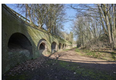
Fossé de gorge vers le nord. Au fond, le pont d'accès au fort. Phot. Pierre Thibaut IVR32_20235900279NUCA
