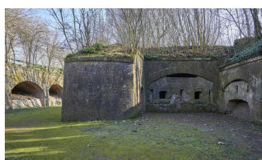
L'orillon gauche de la caponnière double, vers l'est. À droite la galerie de fusillade. Phot. Pierre Thibaut IVR32_20235900288NUCA
