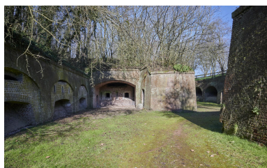
La caponnière double vers le nord-ouest. Phot. Pierre Thibaut IVR32_20235900283NUCA
