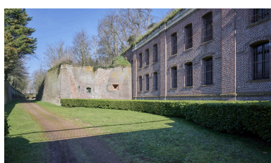
Le fossé de gorge vers le nord. Au centre le coffre de la batterie de flanquement nord avec une embrasure de tir modifiée (ébrasement en gradins). Phot. Pierre Thibaut IVR32_20235900290NUCA
