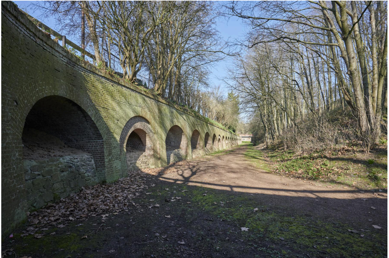
Fossé de gorge vers le nord. Au fond, le pont d'accès au fort.
