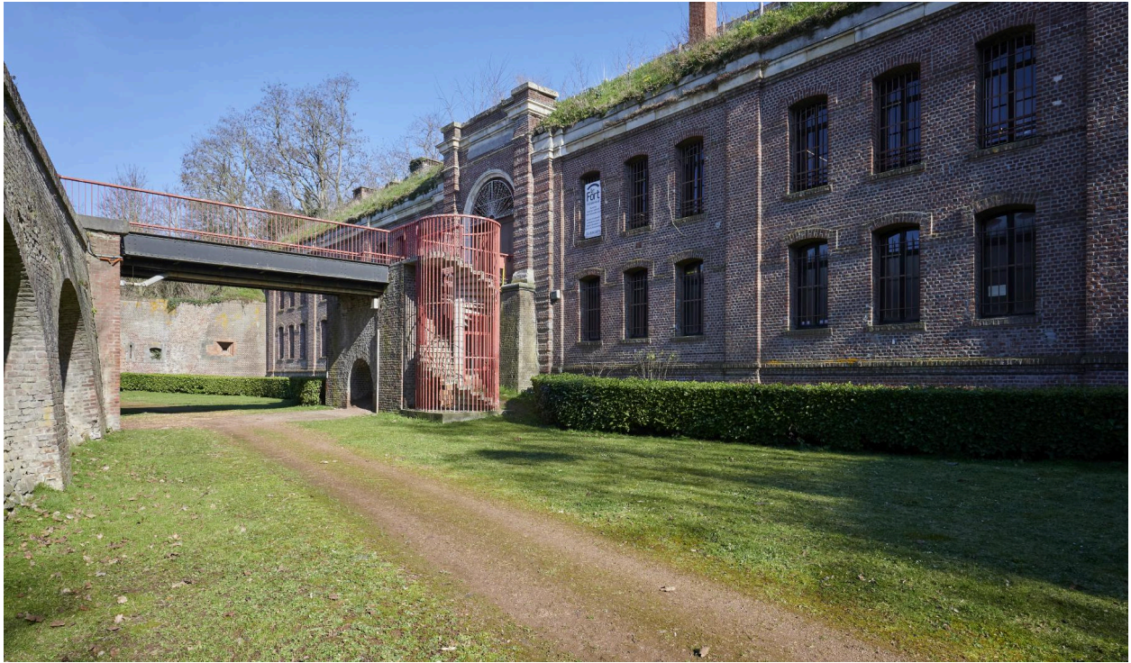
Le casernement de gorge, depuis le fossé, vers le nord.
