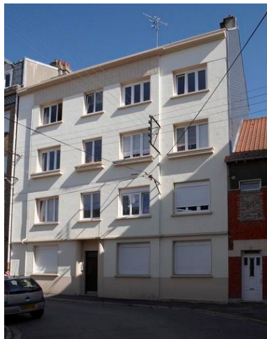
Vue générale. Phot. Pierre Thibaut IVR31_20086200237NUCA
