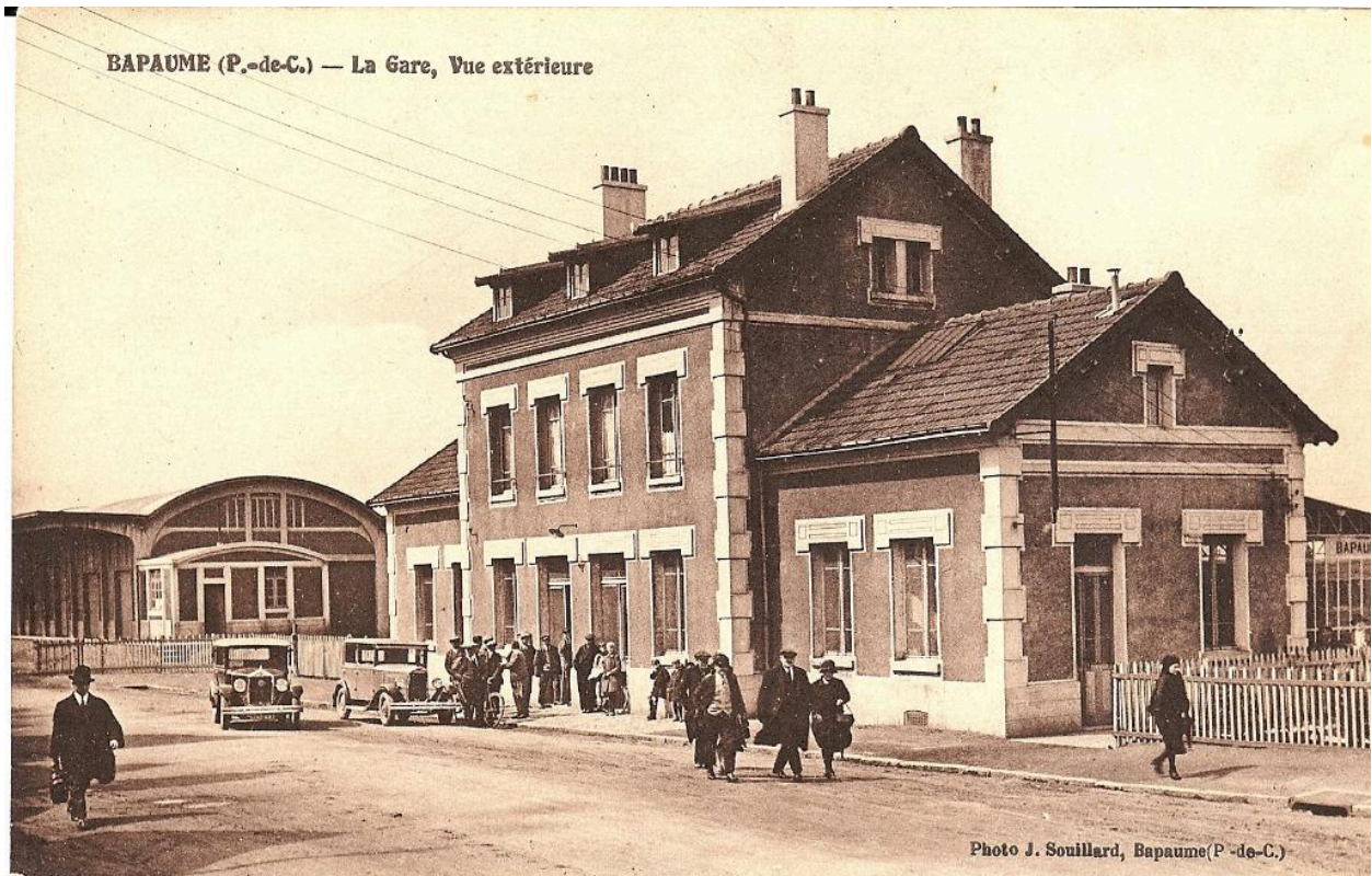
Bapaume (P.-de-C.) - La gare, vue extérieure. Photo J. Souillard, Bapaume. Carte postale, vers 1930. (Coll. part.). Vue générale de la place de la gare reconstruite.
