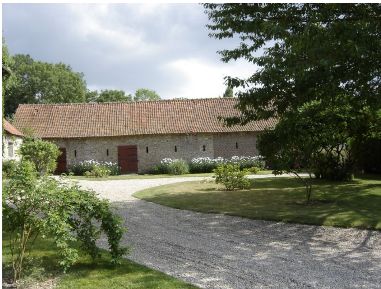
Vue des écuries.
