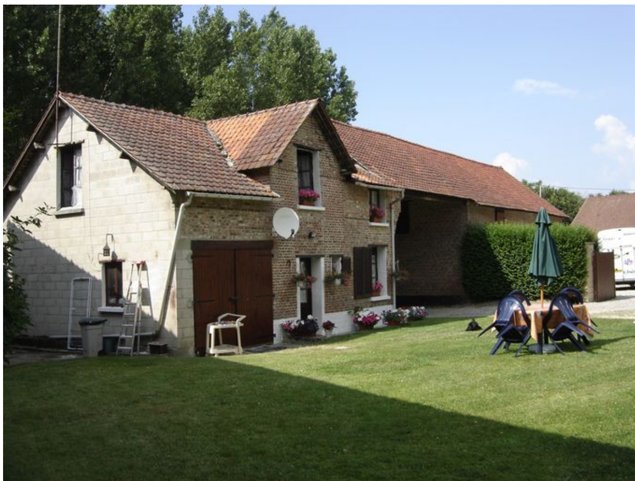
Vue des étables surmontées d'un fenil.
