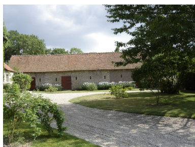
Vue des écuries. Phot. Inès Guérin IVR22_20058006223NUCA
