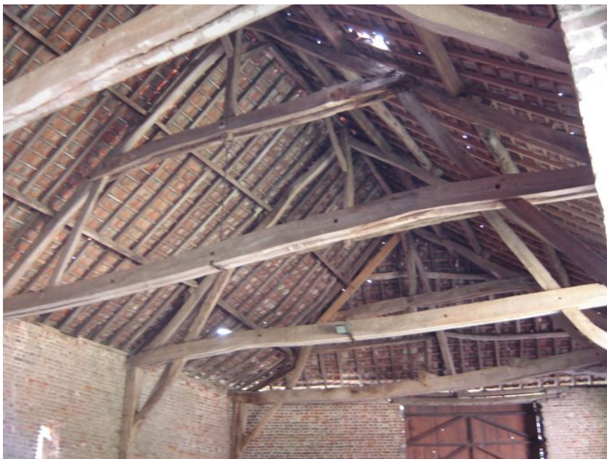
Vue de la charpente.
