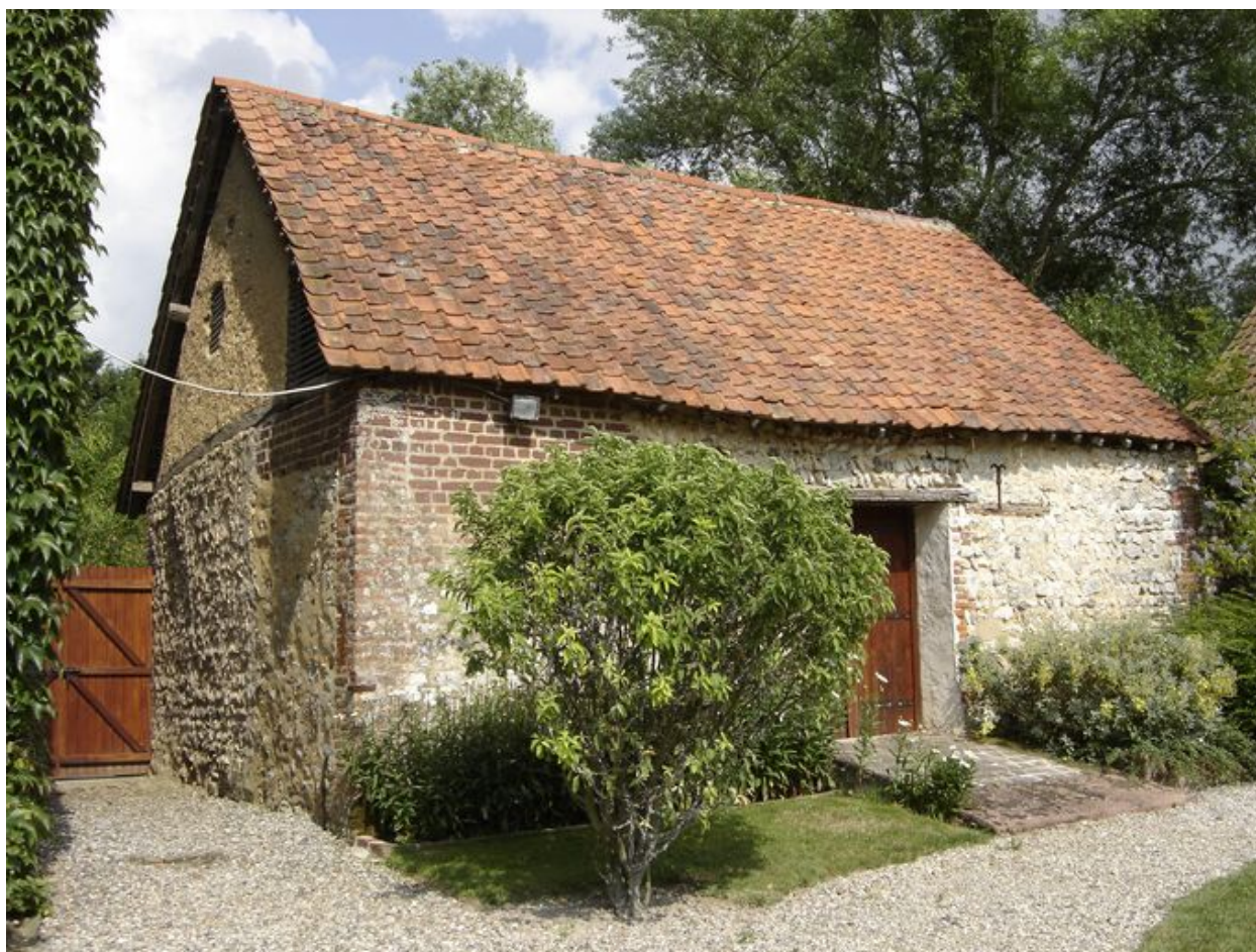
Vue de la remise.
