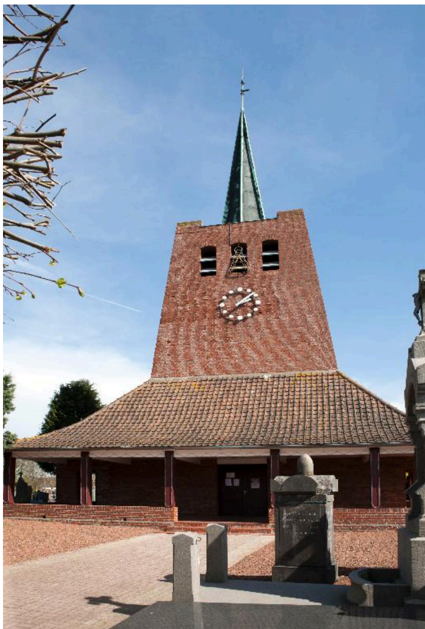
Vue de la façade occidentale.
