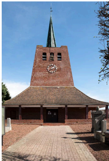
Vue de l'entrée. Phot. Pierre Thibaut IVR31_20145902772NUCA
