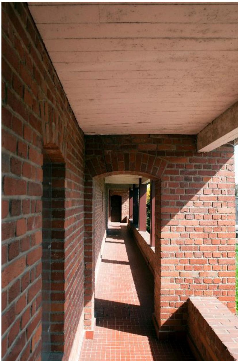
Détail du passage couvert bordant l'édifice.
