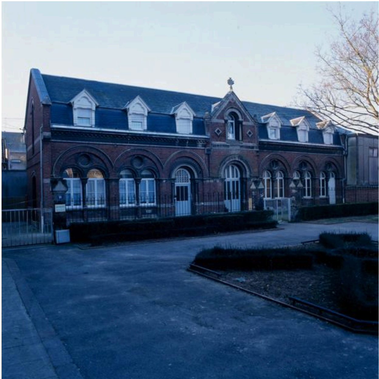
Le presbytère au sud-est de l'église.
