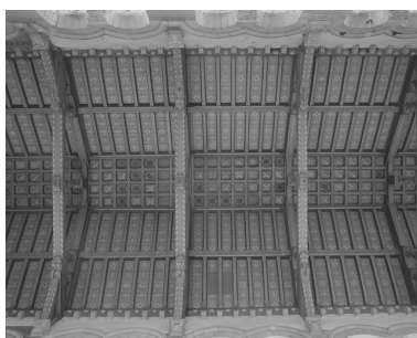
Vue de détail : la charpente de la nef. Phot. Thierry Lefébure IVR22_19968000211X
