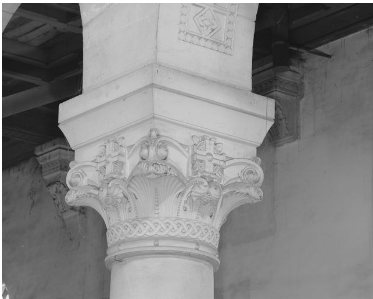
Vue de détail : chapiteau de la nef.
