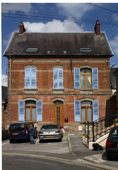
Façade sur rue du logement d'institutrice. Phot. Bertrand Fournier IVR22_20138016068NUC2A
