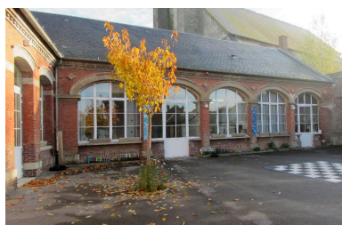
Façade sur cour des salles en retour. Phot. Bertrand Fournier IVR22_20138016095NUC2A
