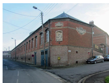
Vue d'ensemble sur rue. Phot. Bertrand Fournier IVR22_20138016094NUC2A
