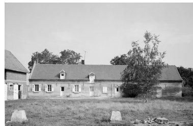
Logis. Elévation antérieure. Phot. Jean-Michel Perrin IVR22_19846001153X
