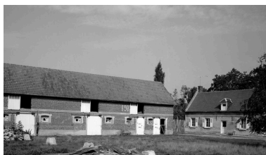
Bâtiments d'exploitation. Phot. Jean-Michel Perrin IVR22_19846001154X
