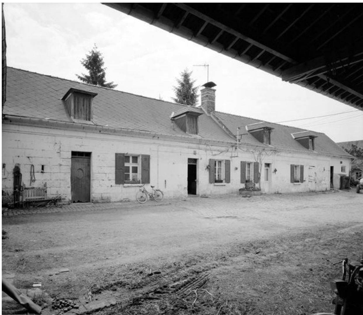
Logis. Elévation antérieure.
