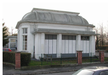
Solarium, état en 2004. Phot. Anita Oger-Leurent IVR31_20065906150NUC
