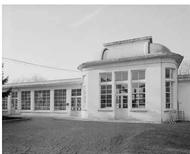
Aile donnant vers le rempart, façade tournée vers la cour de verdure : solarium, état en 2001. Phot. Pierre Thibaut IVR31_20015900940V
