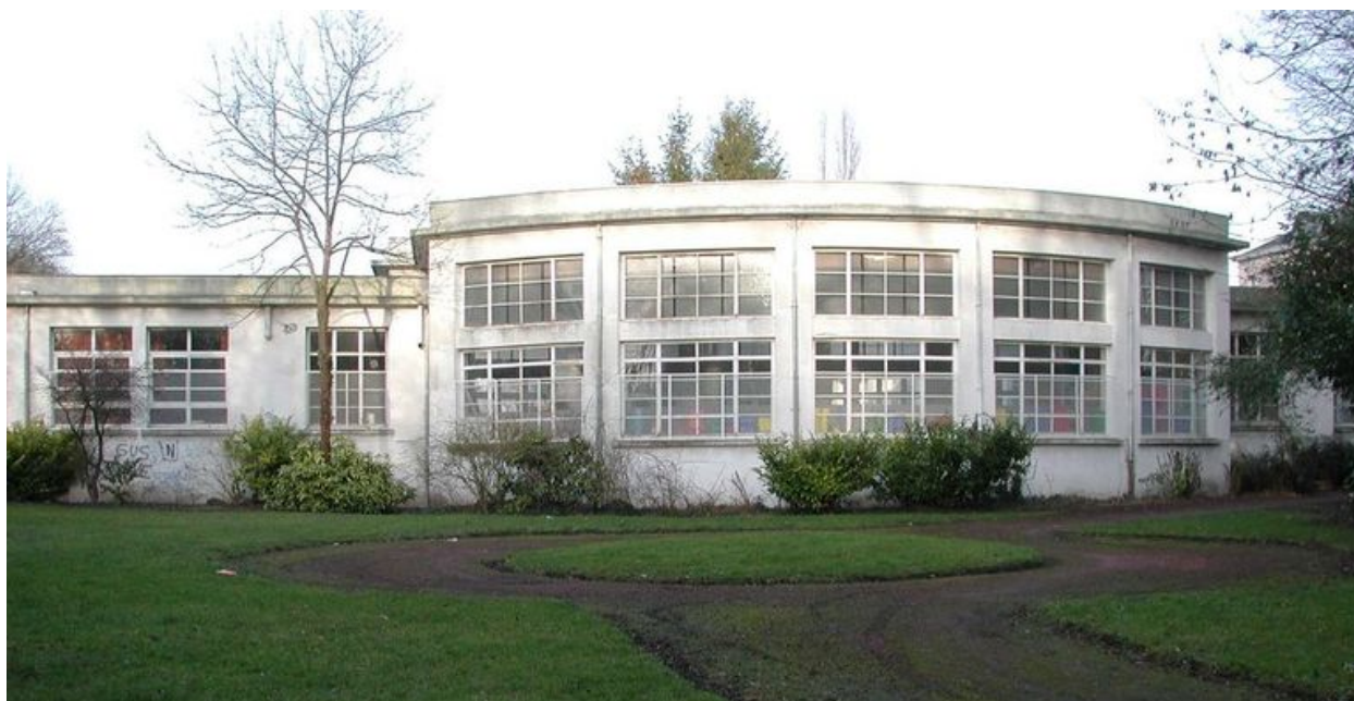
Aile de liaison, corps de bâtiment en avancée, préau chauffé (actuellement salle de jeux).
