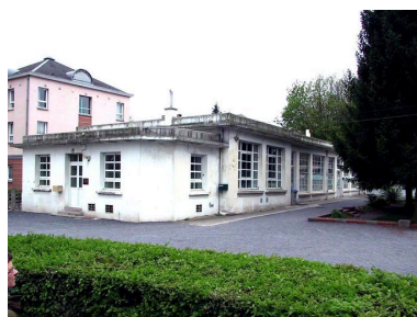
Aile donnant sur le boulevard des Écoles, façade tournée vers la cour de verdure. Phot. Olivier Liardet IVR31_20065906146NUCA
