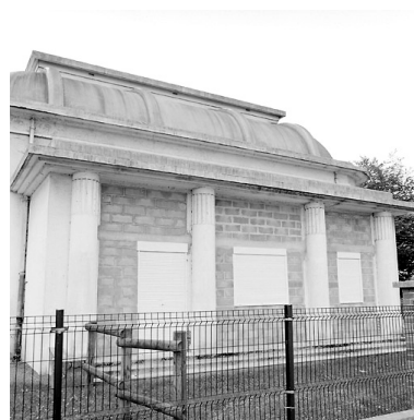
Solarium, état fin 2005. Phot. Pierre Thibaut IVR31_20055900860X
