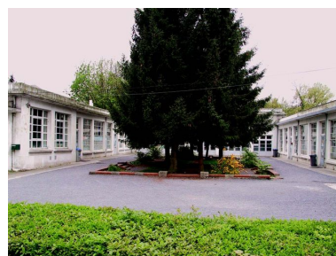
Cour de verdure, vue générale. Phot. Olivier Liardet IVR31_20065906147NUCA
