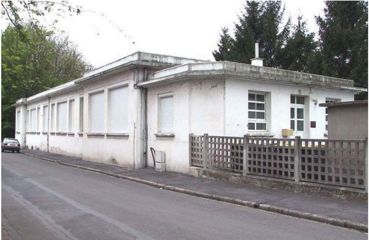
Aile donnant sur le boulevard des Écoles.
