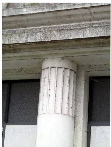
Solarium, détail, état en 2005. Phot. Olivier Liardet IVR31_20065906151NUCA
