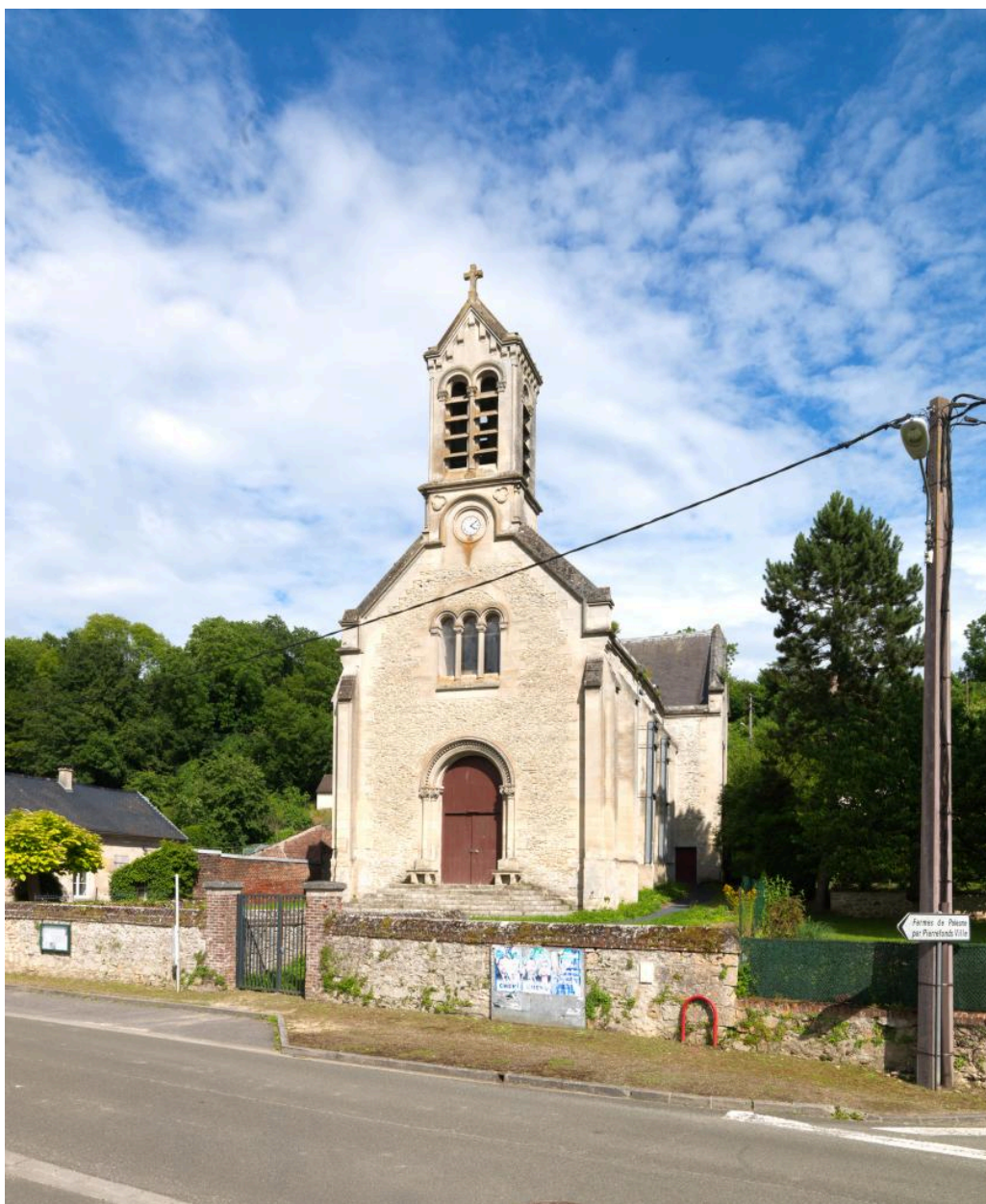
Église, vue depuis l'ouest.
