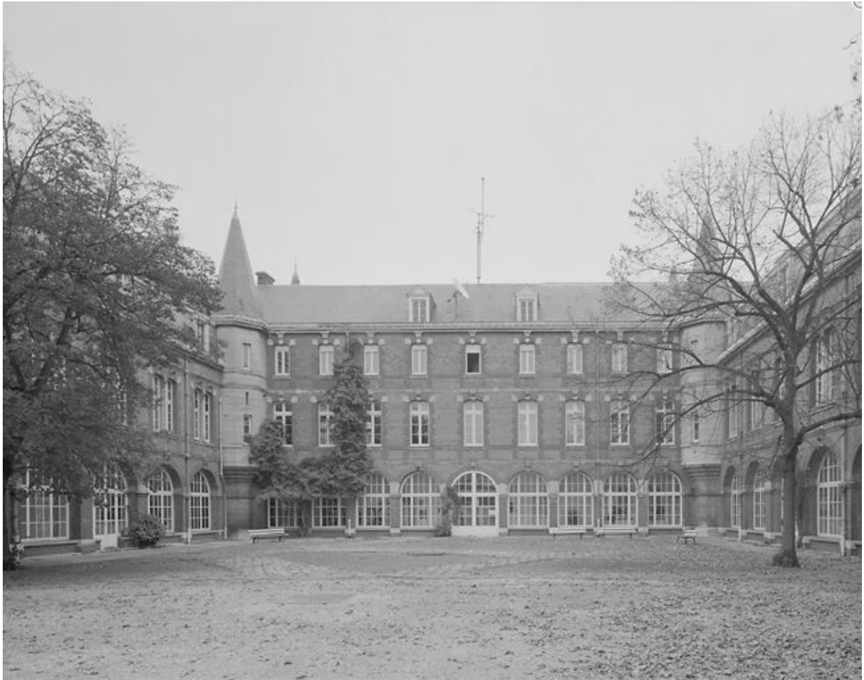
Façade postérieure sur la cour.
