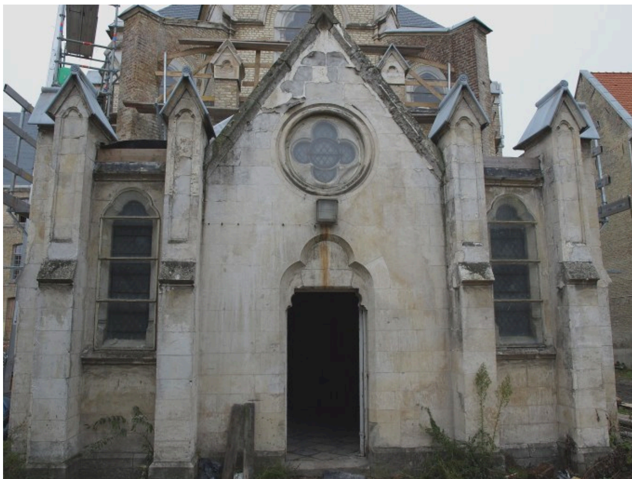
Chapelle, porche donnant accès à la sacristie
