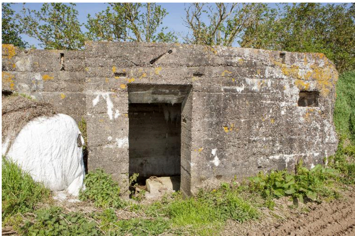
Bâtiment 2, élévation sud-est
