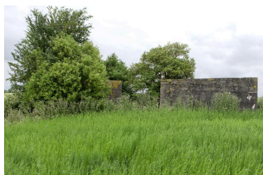
De droite à gauche, les bâtiments 1 et 2, vers l'est Phot. Jean-Marc Ramette IVR31_20145905172NUCA
