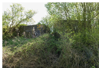
Vue arrière, vers le sud-est des bâtiments 1 (à droite) et 2 Phot. Jean-Marc Ramette IVR31_20145906016NUCA
