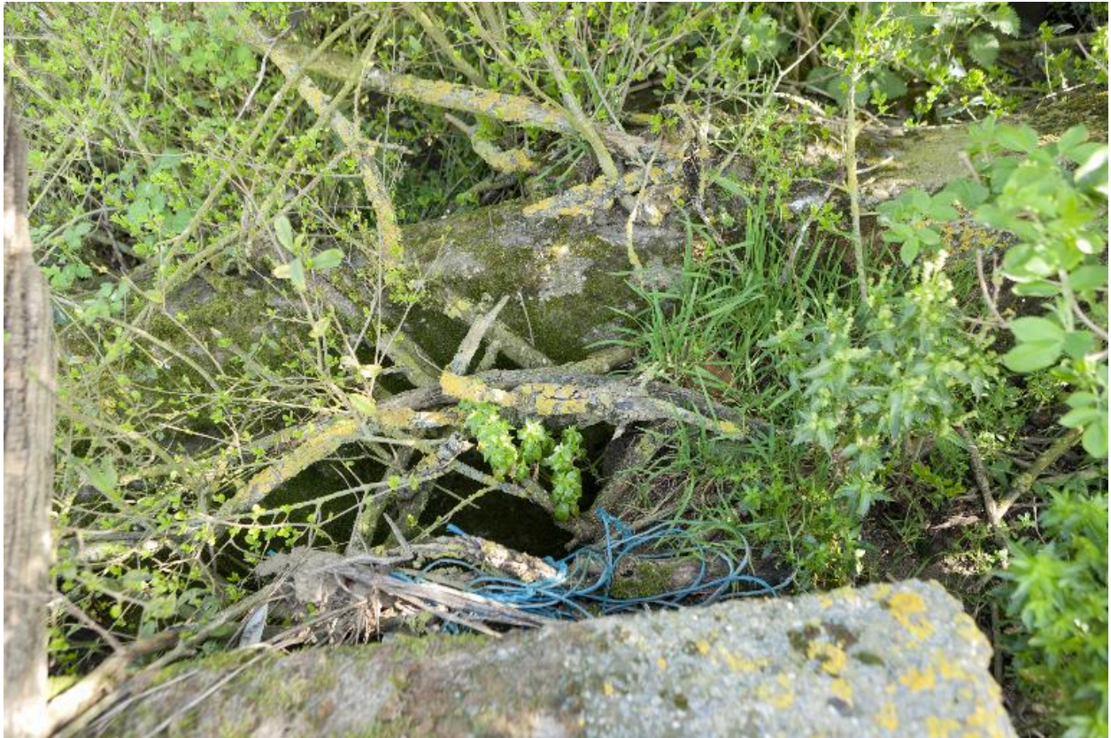
Rigole menant au bâtiment 1, partiellement découverte
