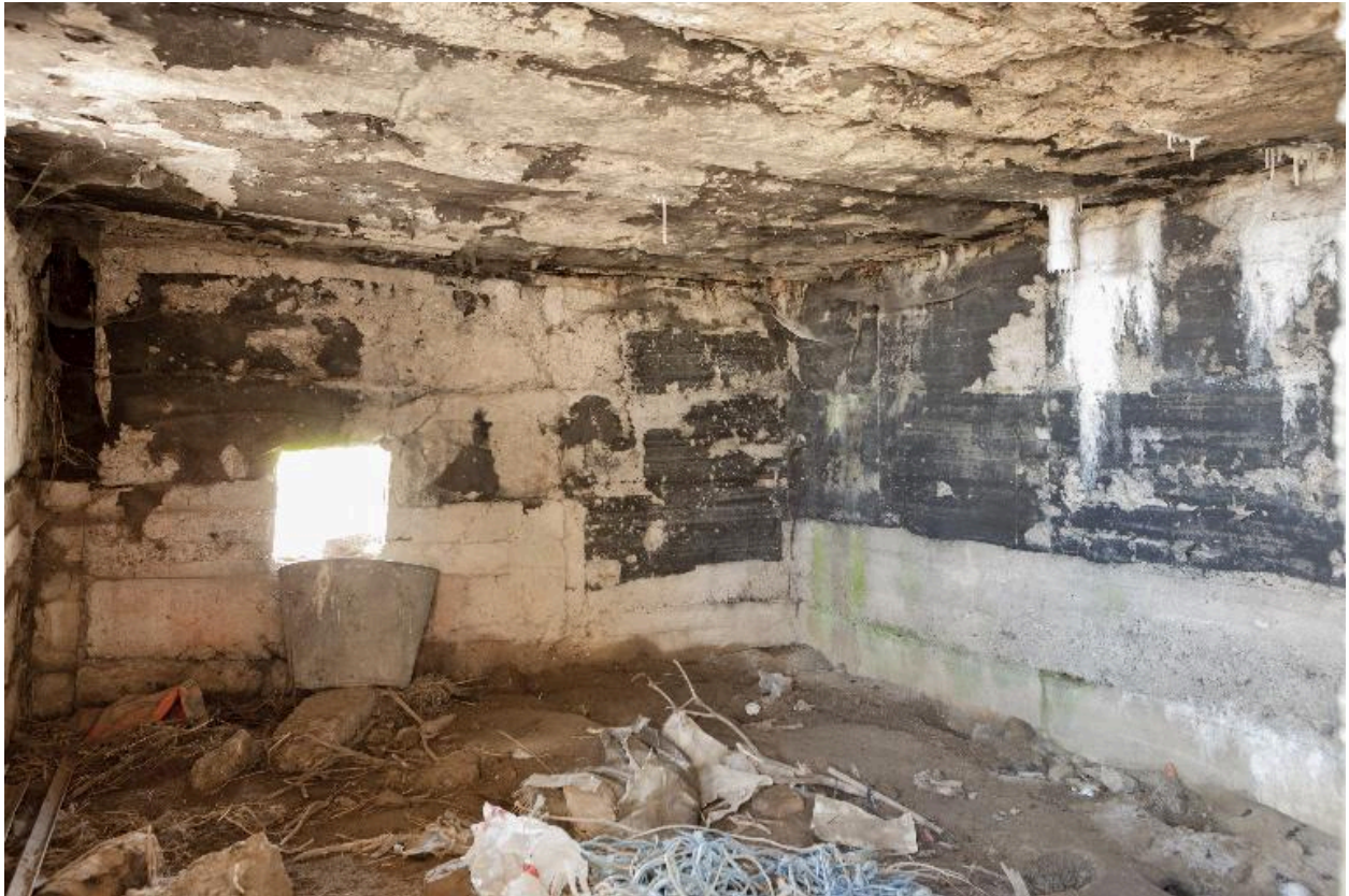
Bâtiment 4, vue intérieure
