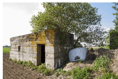
Bâtiment 1 : L'entrée sur élévation ouest Phot. Jean-Marc Ramette IVR31_20145905168NUCA
