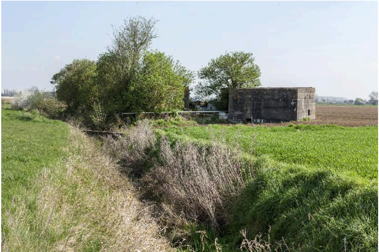
Vue postérieure de l'ensemble, vers le nord-est. Au premier plan, le ruisseau, au centre la rigole bétonnée.
