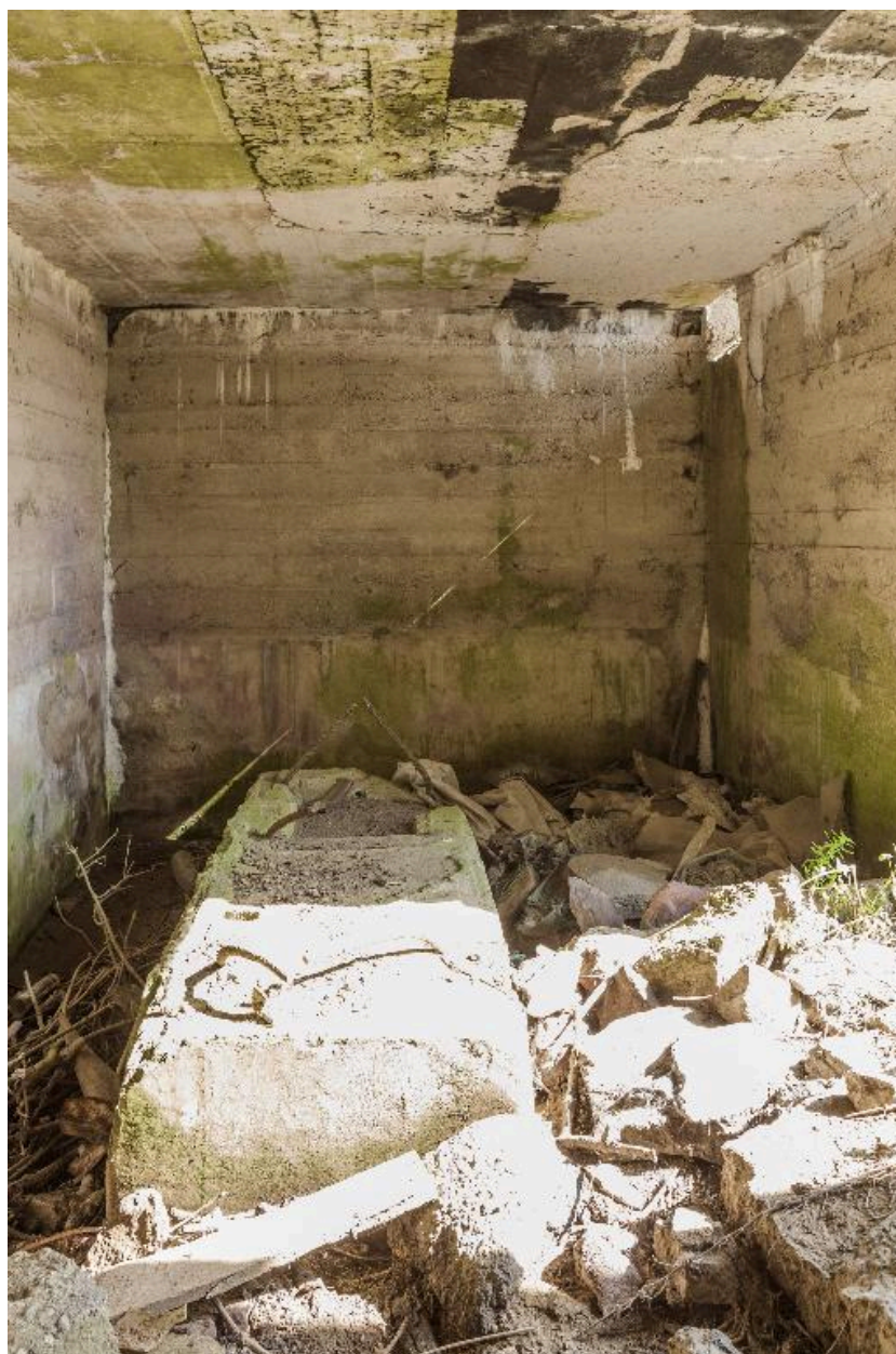
Bâtiment 2, massif bétonné des pompes
