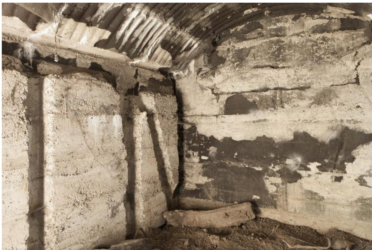
Bâtiment 1, vue intérieure
