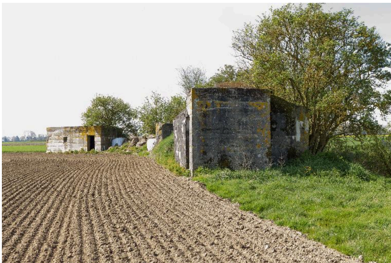
Vue d'ensemble vers le sud-ouest. Au premier plan le bâtiment 4 avec son entrée pare-souffle (?)
