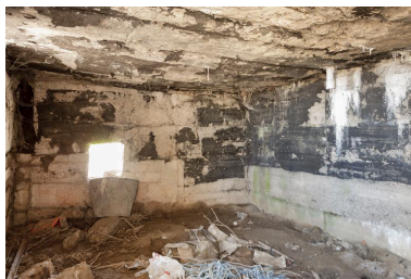
Bâtiment 4, vue intérieure Phot. Jean-Marc Ramette IVR31_20145905161NUCA
