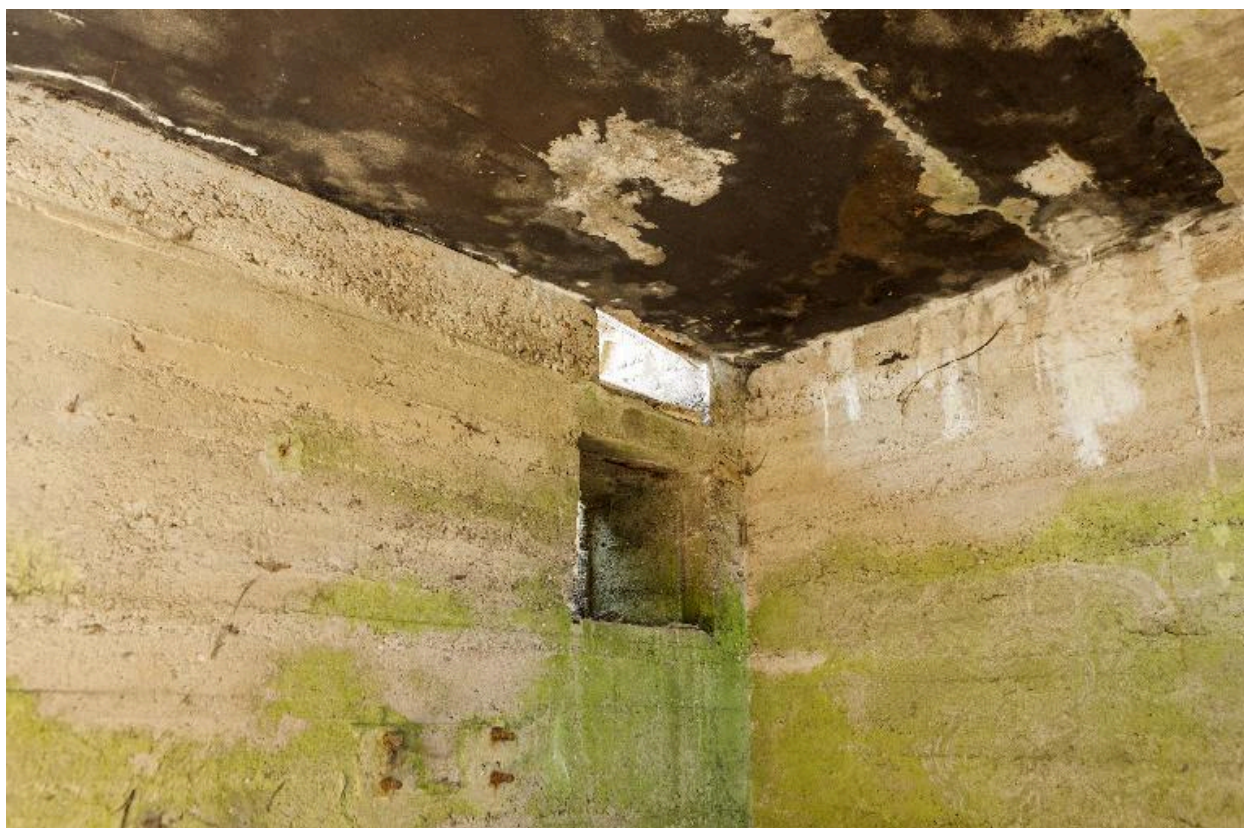
Bâtiment 2, vue intérieure
