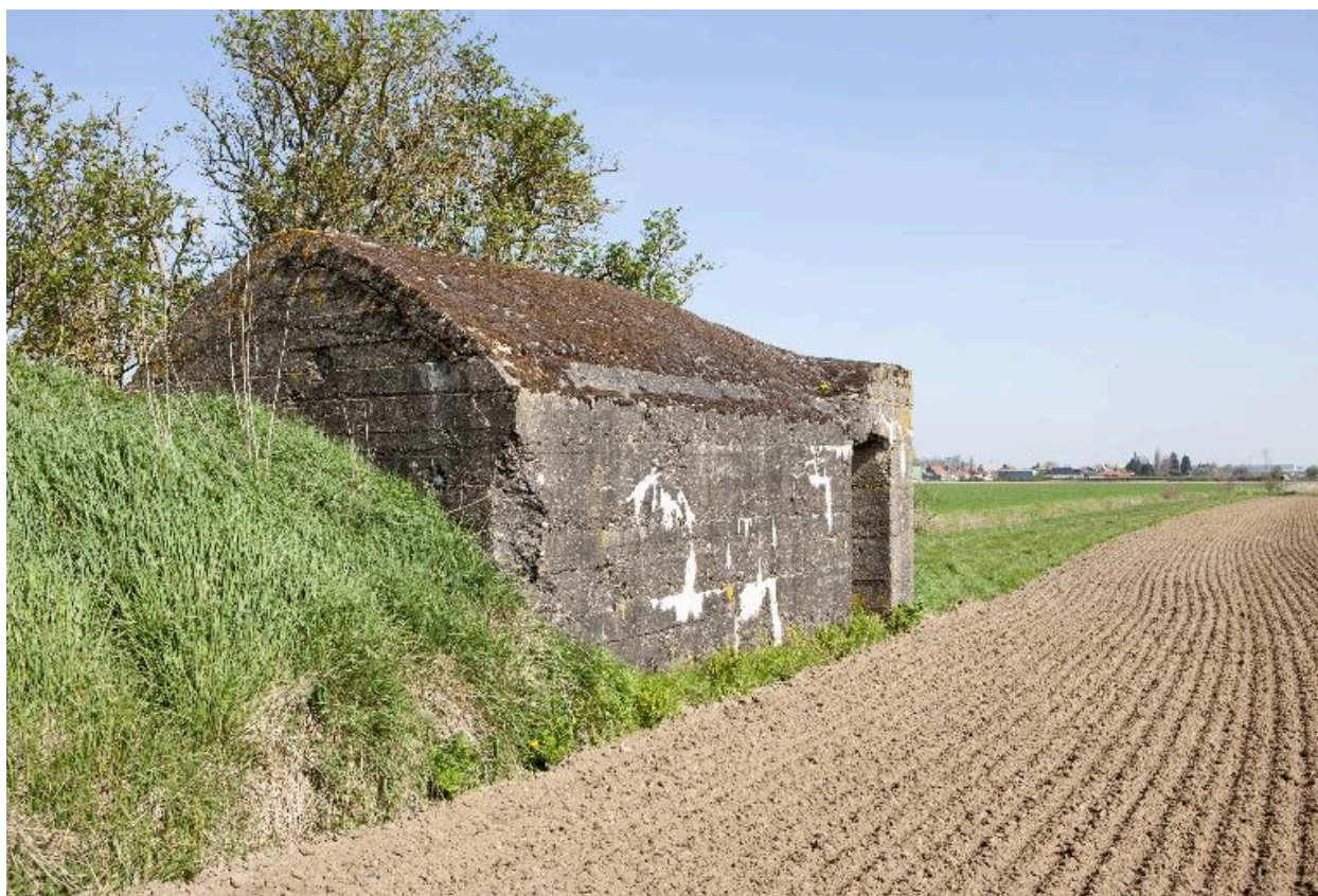
Bâtiment 4, élévation sud-est. A gauche le bâtiment 3 ?
