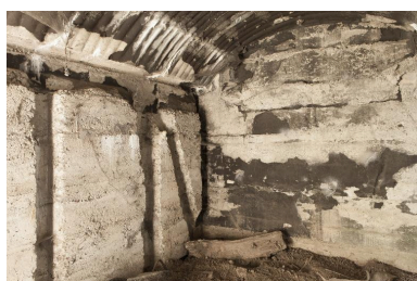
Bâtiment 1, vue intérieure Phot. Jean-Marc Ramette IVR31_20145905169NUCA
