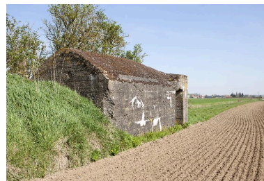
Bâtiment 4, élévation sud-est. A gauche le bâtiment 3 ? Phot. Jean-Marc Ramette IVR31_20145905159NUCA
