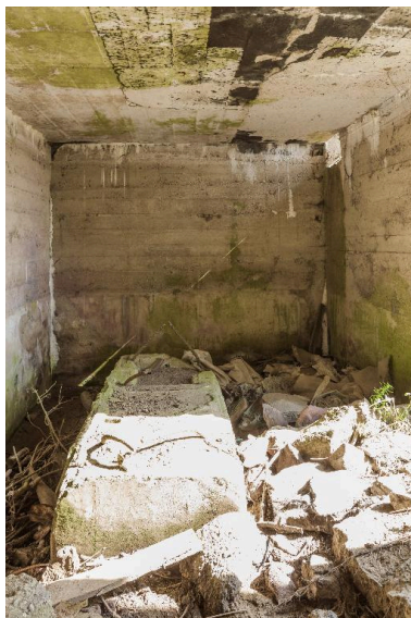
Bâtiment 2, massif bétonné des pompes Phot. Jean-Marc Ramette IVR31_20145905163NUCA
