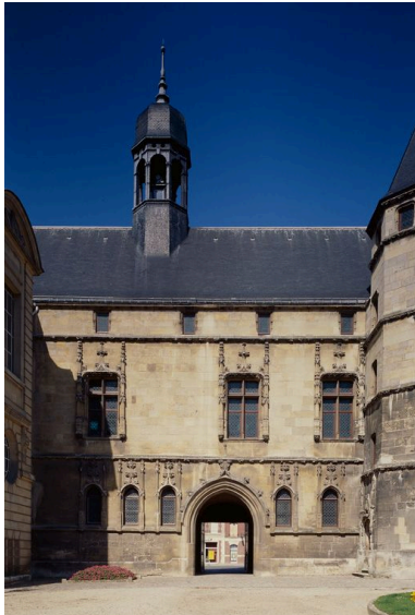
Élévation postérieure, détail. Phot. Fabrice Charrondière IVR22_19856001293XA
