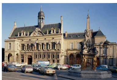
Elévation antérieure. Phot. Fabrice Charrondière IVR22_19856001271XA
